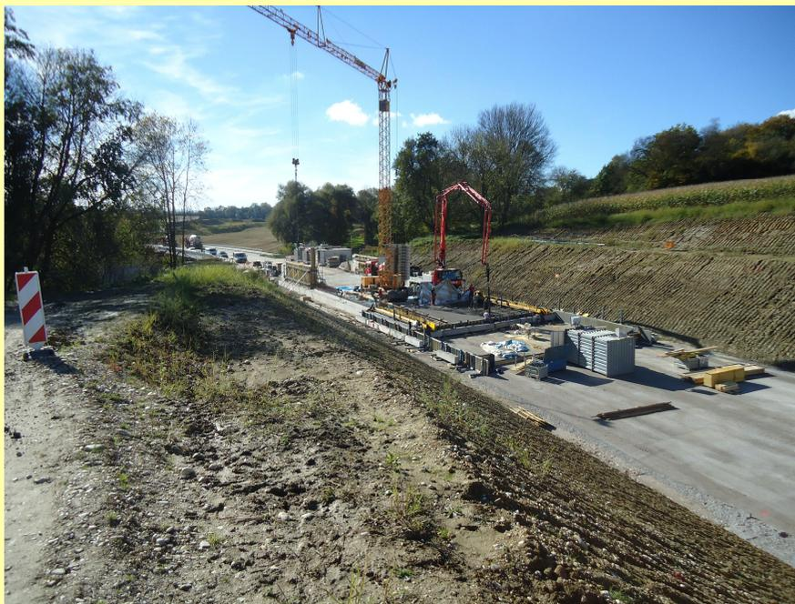
(Abb.: Betonierarbeiten im Anschluss an Schwaigerbachquerung)
