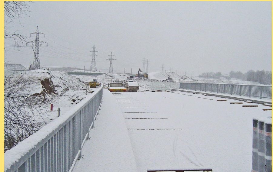
(Abb.: Blick von der Schwaigerbachbrücke Richtung Westbahnunterführung)
