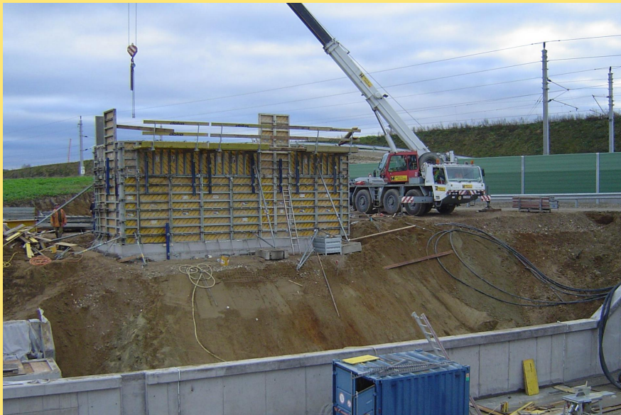
(Abb.: Betriebsgebäude Pumpwerk Lambach ÖBB-Querung)
