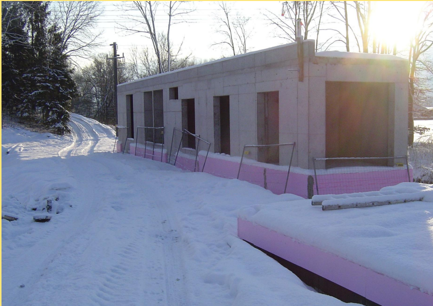
(Abb.: Rohbau Betriebsgebäude Lambach Drucksteigerungsanlage)
