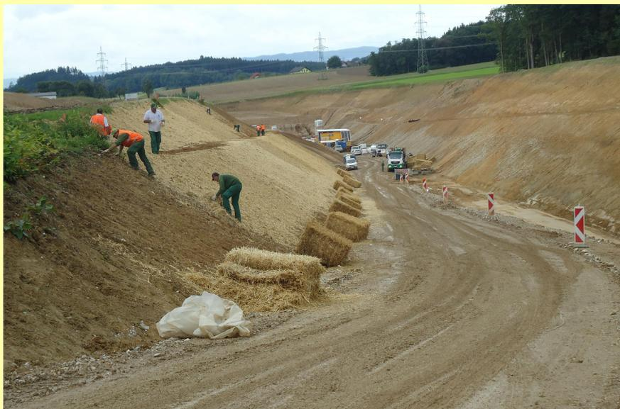
(Abb.: Böschungsbegrünung mittels Strohecksaat)
