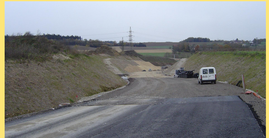
(Abb.: Blick vom Kreisverkehr West Richtung Westbahnunterführung)
