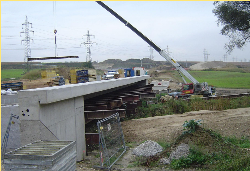
(Abb.: Arbeiten im Bereich des Schwaigerbaches)
