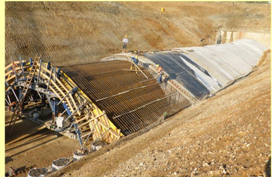
(Abb.: Tunnelabschnitt in Deckelbauweise)
