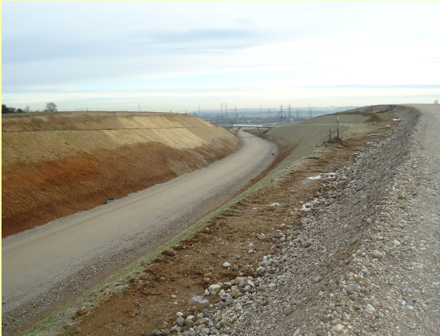
(Abb.: Blick auf Brückenobjekt „Schlinkerleitenstraße“ )
