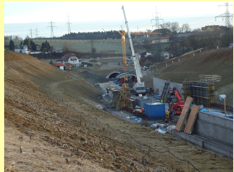
(Abb.: Blick auf Tunnel im Bereich der Offenhausener Straße)
