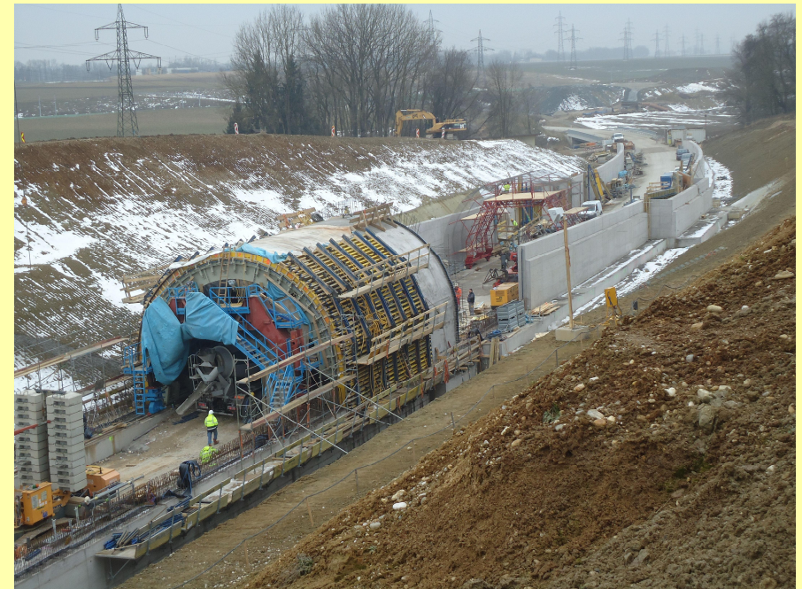
(Abb.: Blick auf Tunnelbaustelle)
