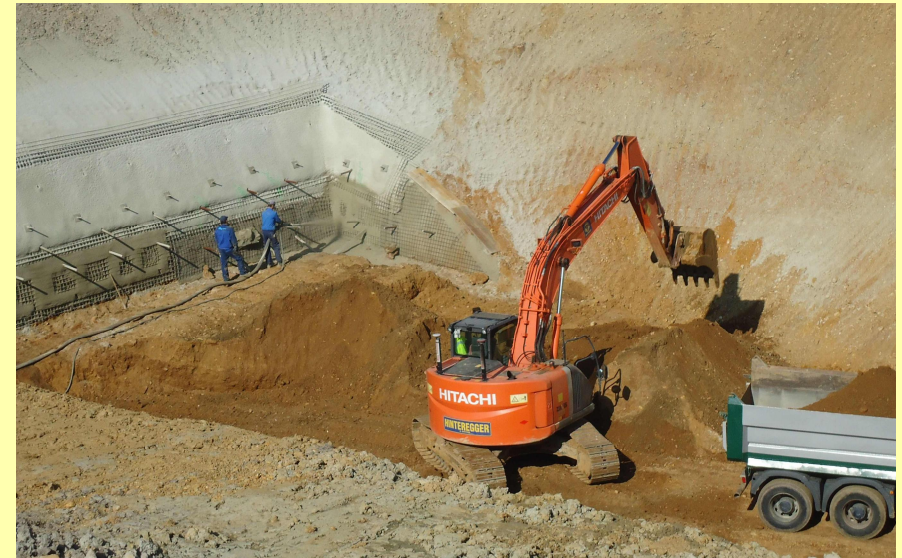
(Abb.: Sicherungsarbeiten im Bereich des Tunnelportals)
