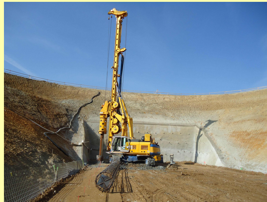
(Abb.: Herstellung von Bohrpfehlen im Bereich des Tunnelportals)
