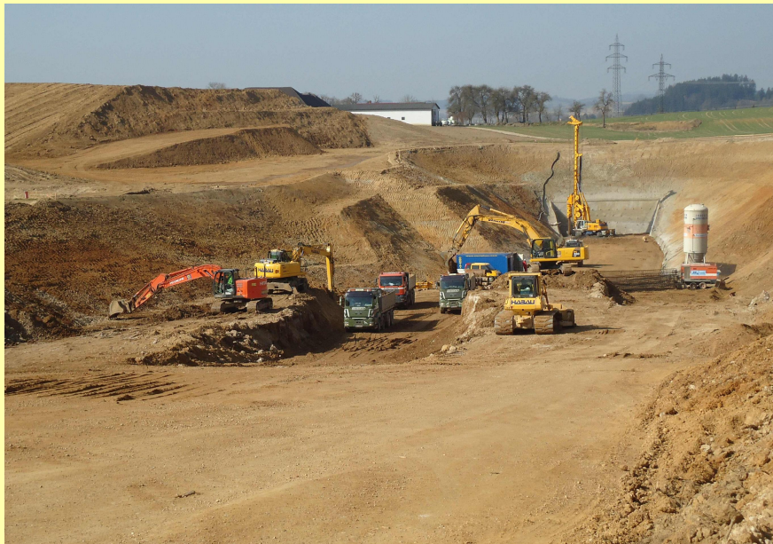
(Abb.: Aushubarbeiten im Vorfeld der Tunnelbauarbeiten)
