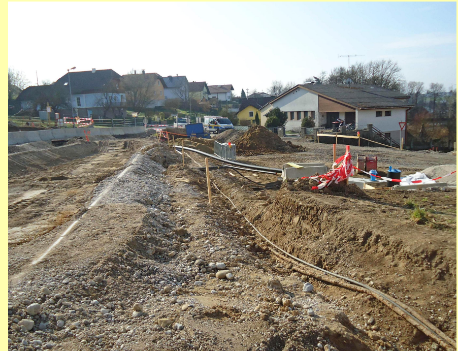
(Abb.: Arbeiten im Bereich der Offenhausener Straße)
