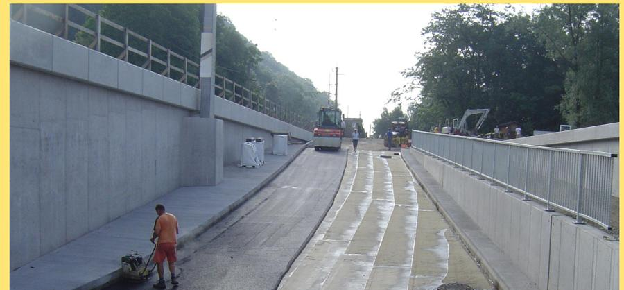
(Abb.: Asphaltierungsarbeiten im Unterführungsbereich)
