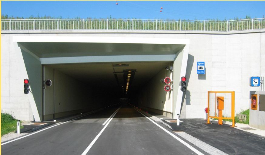
(Abb.: Tunnelportal mit Notrufeinrichtung)
