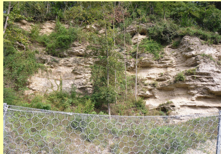
(Abb.: Steinschlagverbauung)
