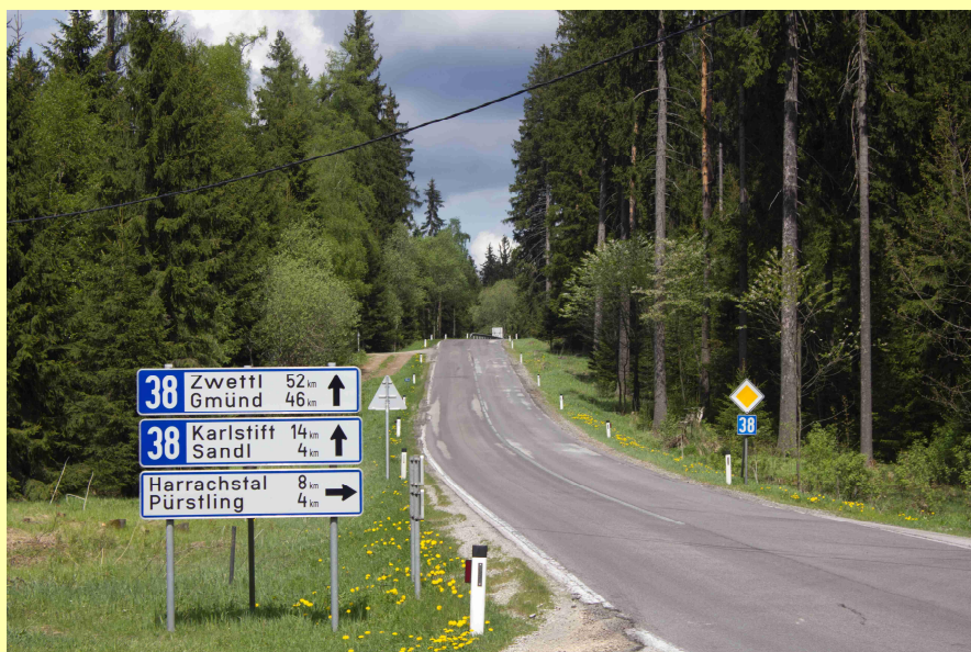
(Abb.: Bestandsaufnahme B38 im Bereich Baulosende)
