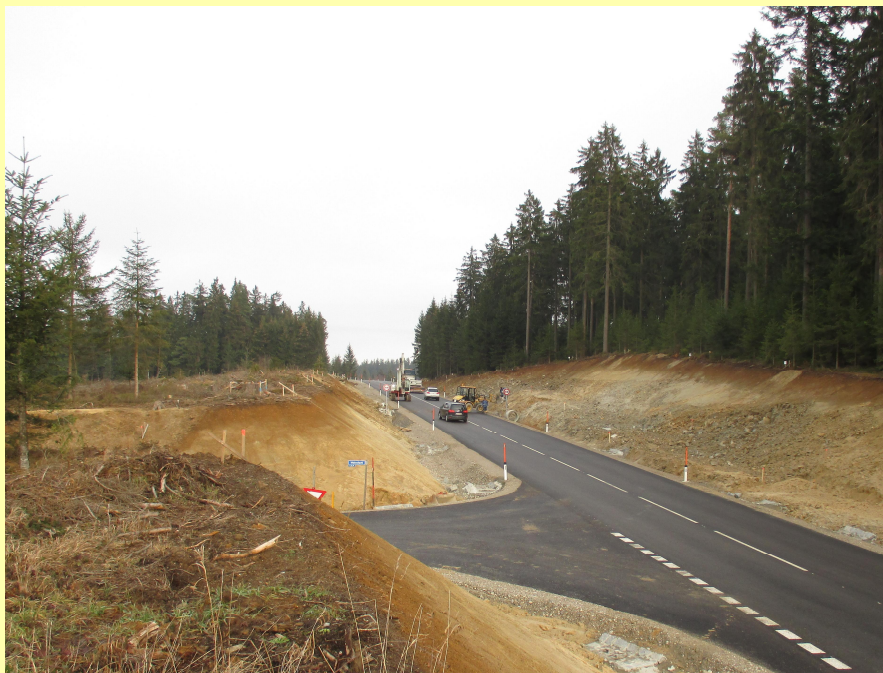
(Abb.: Bauarbeiten – Dezember 2015)
