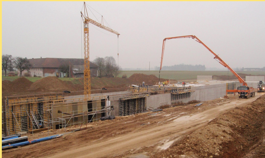
(Abb.: Grünbrücke Metz)
