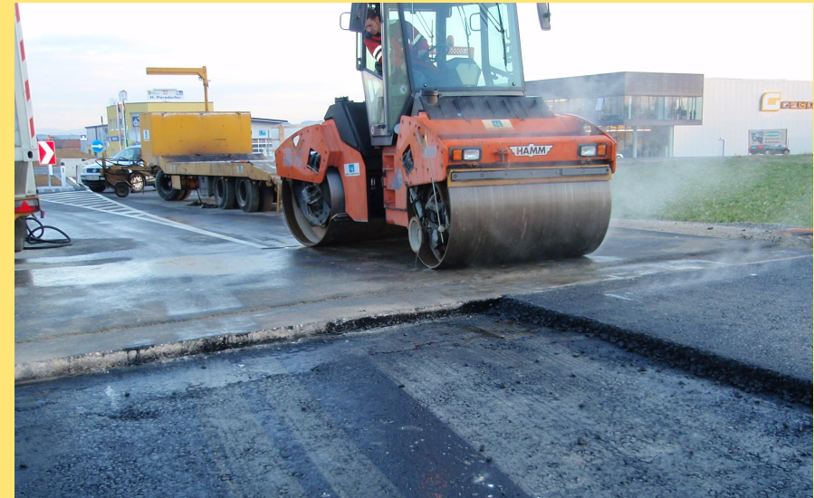
(Abb.: Asphaltierungsarbeiten alte B 1)
