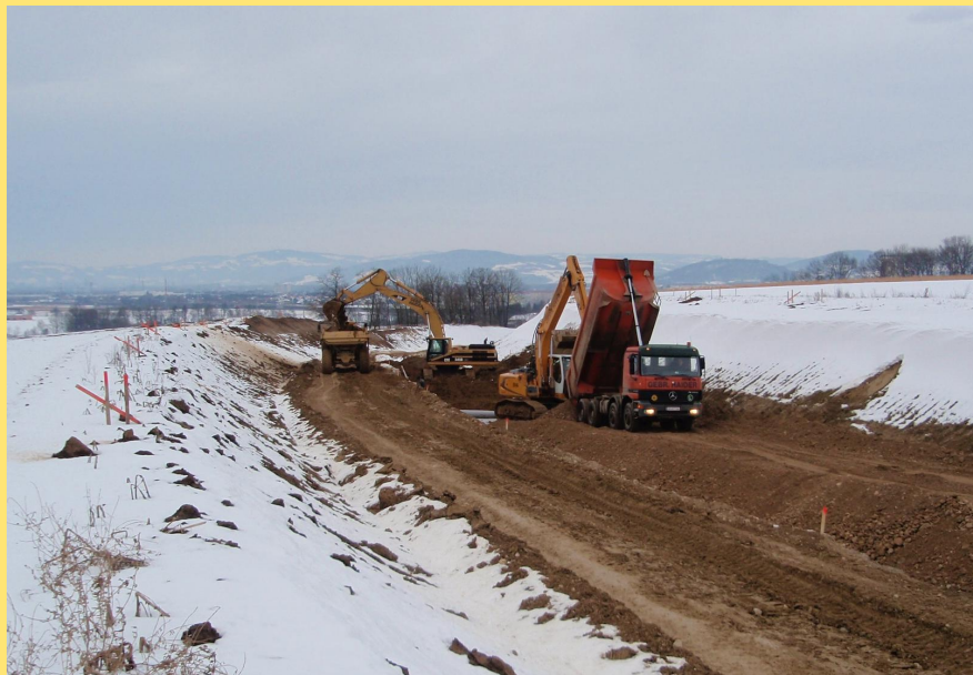
(Abb.: Erdbauarbeiten Bereich Volkersdorf)
