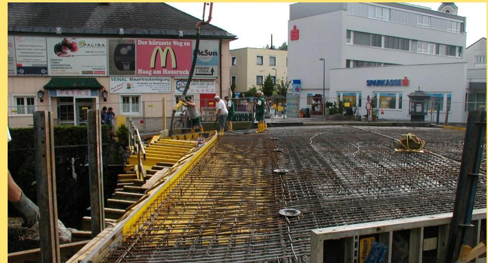
(Abb.: Betonieren des Brückentragwerks nach der Herstellung der Widerlager)
