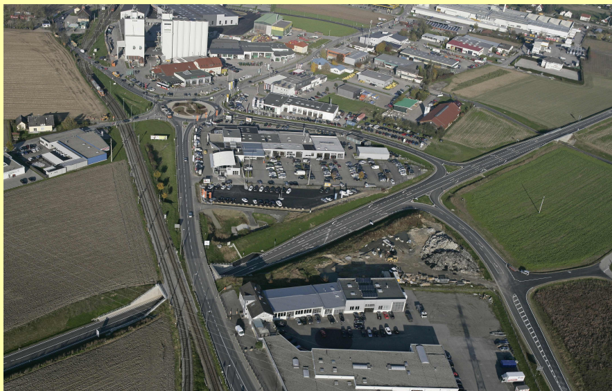
(Abb.: Umfahrung Eferding 1. Teil – Unterführung B134/LILO/OBB)
