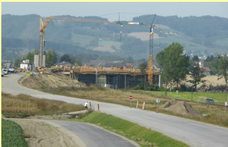
(Abb.: Errichtung Kutschermühlbachbrücke – September 2015)
