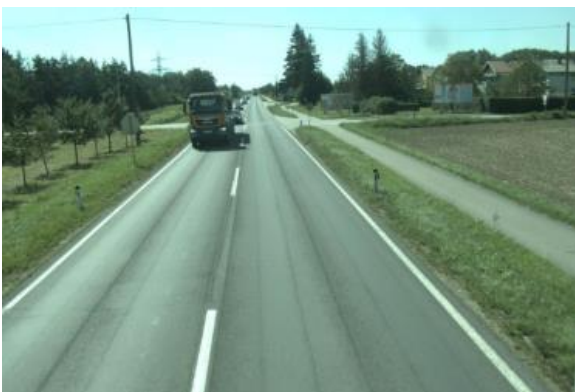
Abb.: Kreuzung B1 – Haidstraße (vor Errichtung Fahrbahnteiler)
