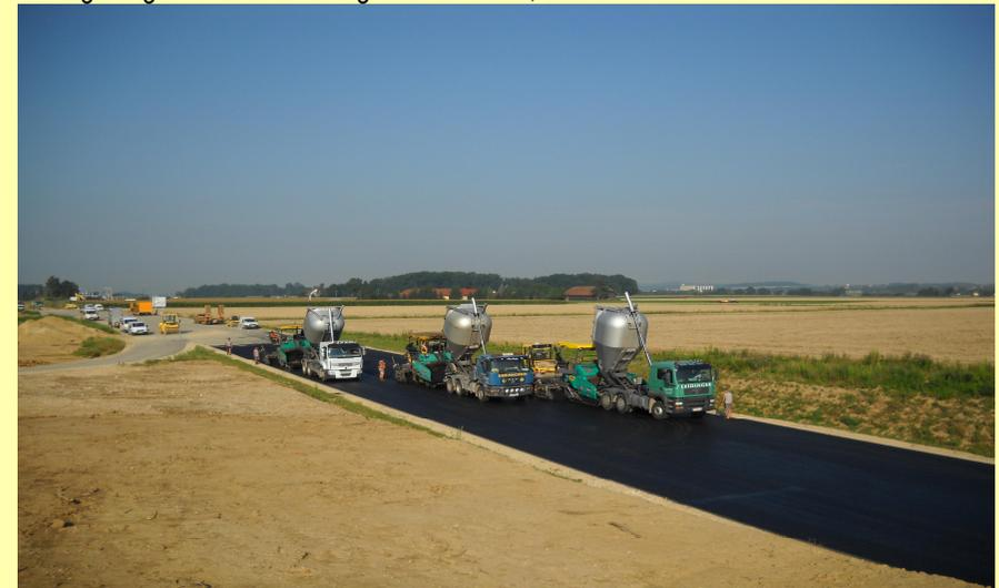
(Abb.: Einbau der Asphaltdecke)
