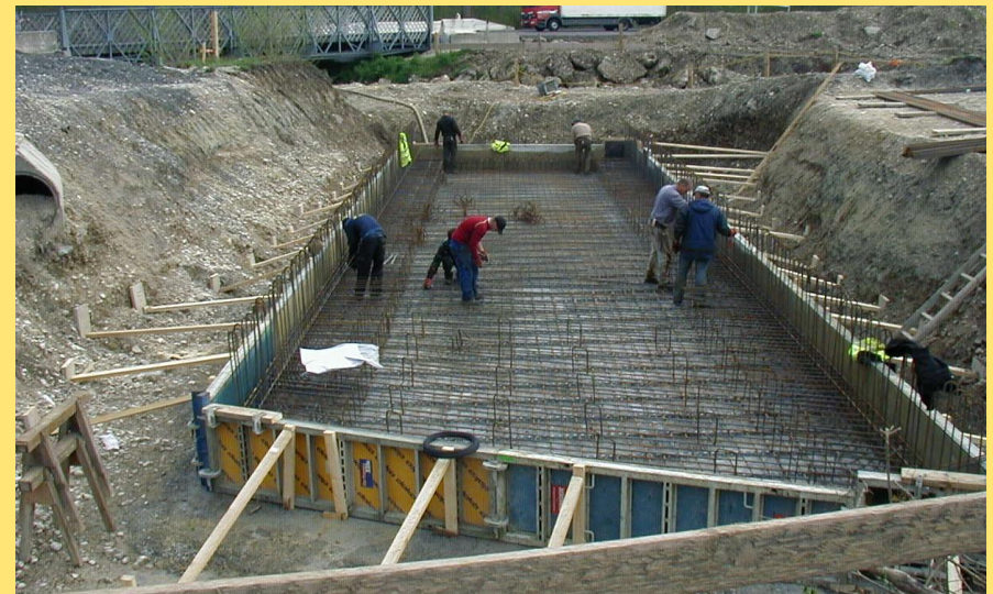
(Abb.: Fundamentierungsarbeiten)
