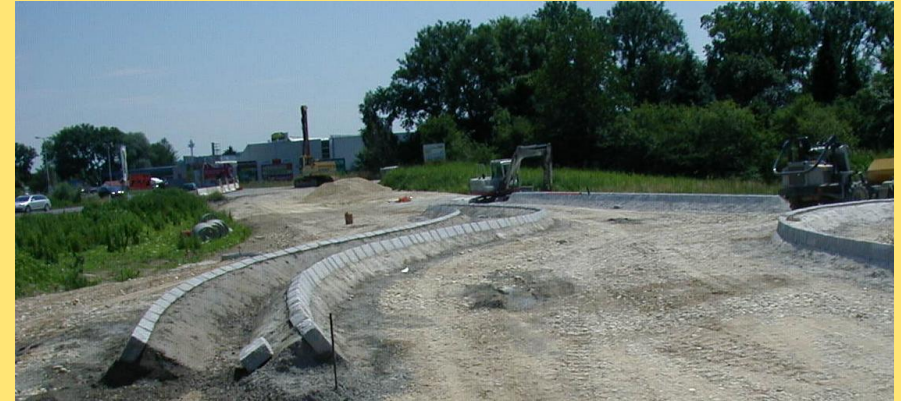
(Abb.: Randeinfassung Betonkreisverkehr)
