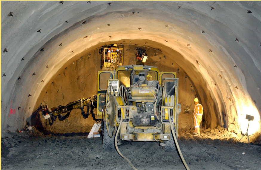
(Abb.: Spritzbetonarbeiten)
