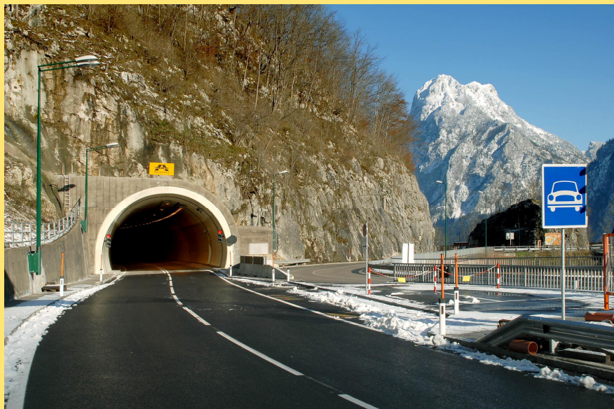
(Abb.: Geisswandtunnel Südportal)
