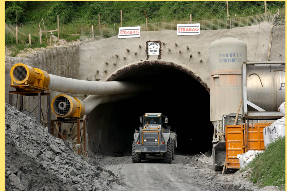
(Abb.: Geisswandtunnel Erkundungsstollen)
