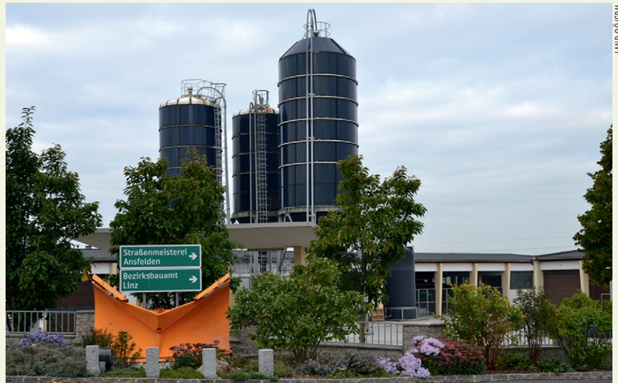
Salzsilos am Areal der Straßenmeisterei
