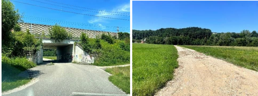
Abbildung 18: Beispiel KAT A-B: Wenig frequentierte Unterführung mit guten Anschlüssen in der Gemeinde Vöcklabruck (Zwangspunkt B03)
