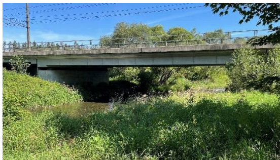
Abbildung 17: Beispiel KAT A: Eisenbahnbrücke im Bereich der Vöckla (Zwangspunkt B05) in der Gemeinde Gampern
