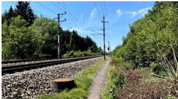
Abbildung 19: Beispiel KAT A-B: Freie Bahnstrecke mit guten Anschlüssen an das Freiraumnetz (Zwangspunkt B01), Gemeinde Attnang-Puchheim
