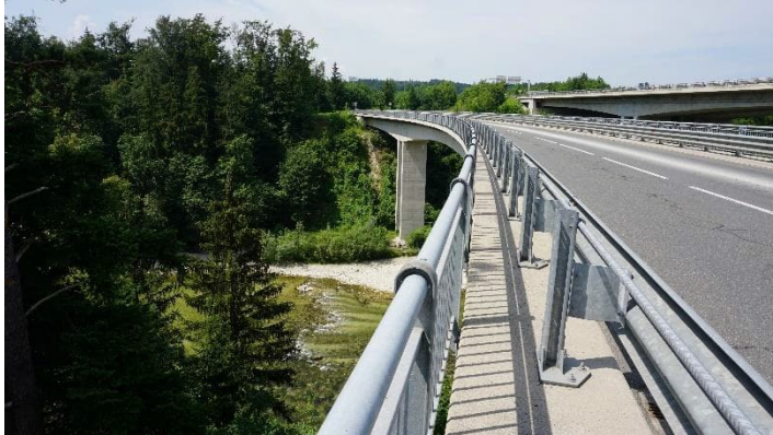
Abbildung 13: Beispiel KAT A: Autobahnbrücke in der Gemeinde Laakirchen (Zwangspunkt A33)
