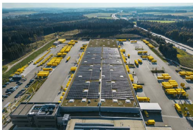
©Österreichische Post AG – Dachbegrünung
