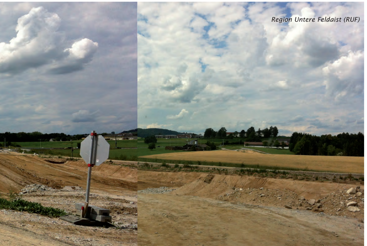
Abbildung: Bauarbeiten im künftigen Gewerbepark AS Unterweikersdorf
