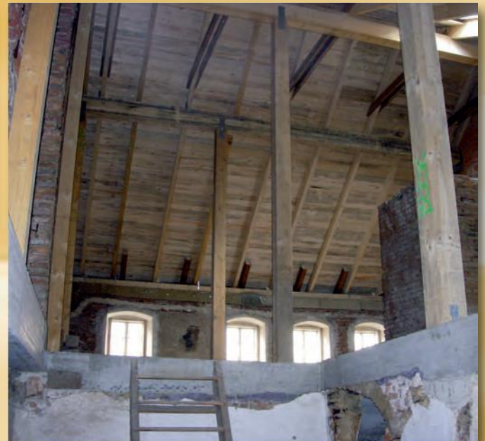
Abbildung 3: Einblicke in die Baustruktur der Windgasse (Quelle: DI Josef Schütz)
