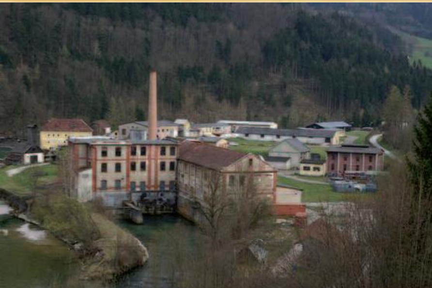
Abbildung 2: Ehem. Haunoldmühle in Obergrünburg (Quelle: Priester Consulting GmbH)
