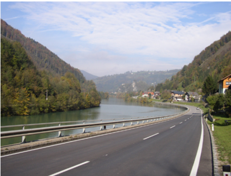
Foto 10008: Ennsfluss mit angrenzender Straße, Nähe Einmündung Trattenbach
