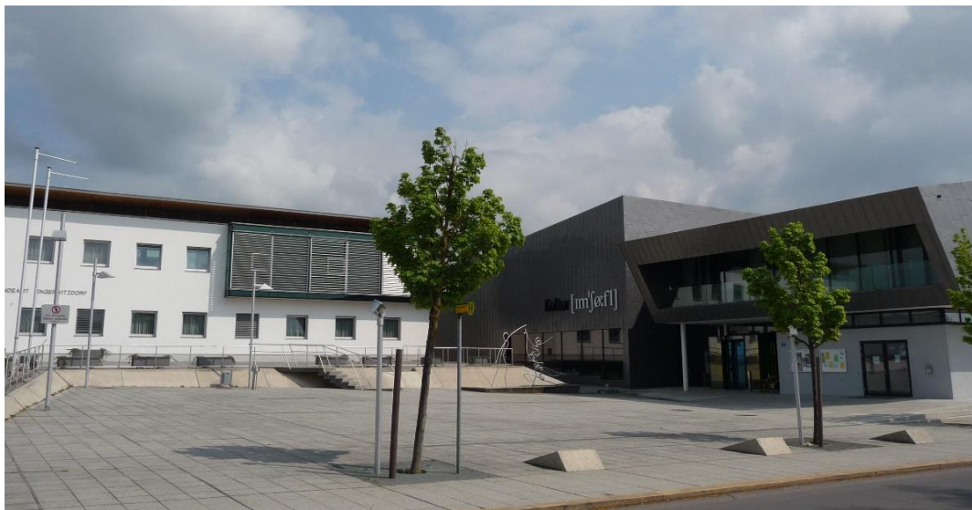
Abbildung 1: Ortszentrum Schweinbach – Gemeindeamt, Kulturhaus und Ortsplatz
