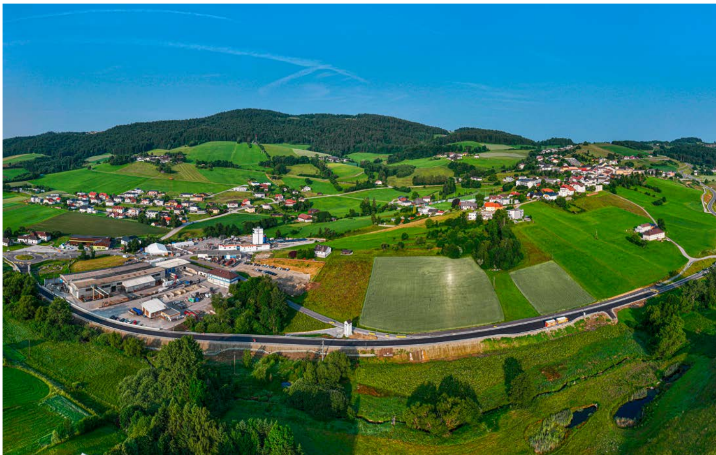
Die fertiggestellte Umfahrung Peilstein.
