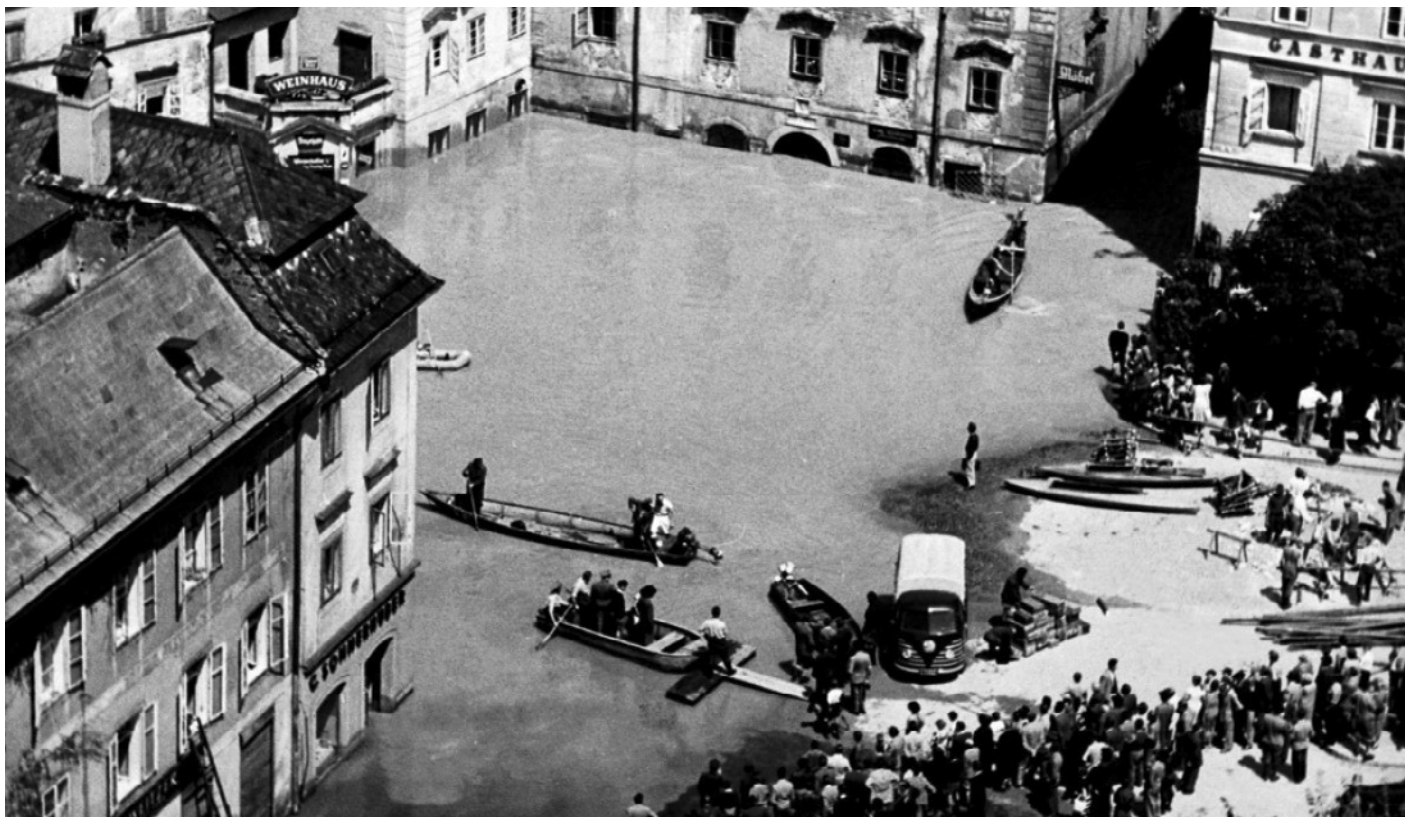
Der überschwemmte Pfarrplatz in der Linzer Altstadt.
