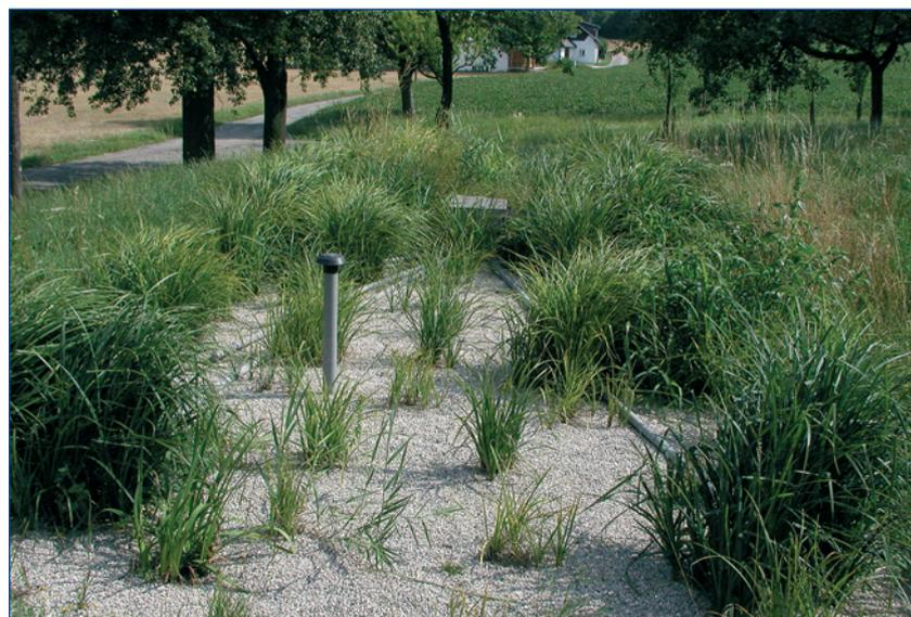
Bild eines vertikal durchströmten Bodenfilters
