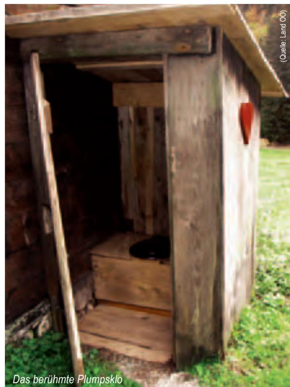
Plumpsklo ist der umgangssprachliche Begriff für eine Toilette ohne Wasserspülung, d. h. ein sogenanntes Trockenklo. Der Kot samt Urin fällt in einen Kasten oder eine Grube und verbleibt dort, bis der Kasten bzw. die Grube gefüllt ist und der Inhalt ausgebracht wird.
