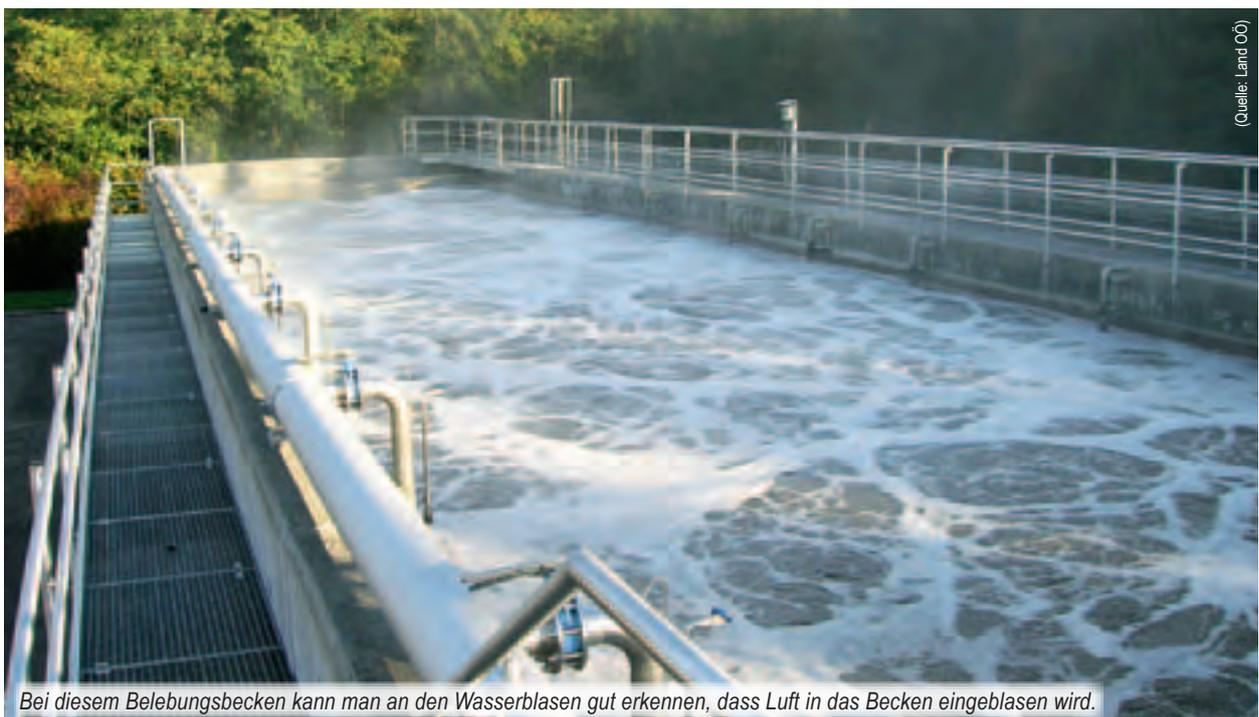
Bei diesem Belebungsbecken kann man an den Wasserblasen gut erkennen, dass Luft in das Becken eingeblasen wird.
