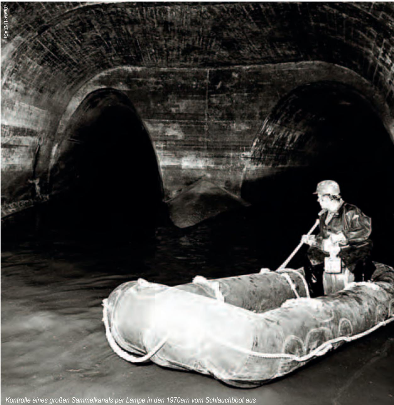
Kontrolle eines großen Sammelkanals per Lampe in den 1970ern vom Schlauchboot aus
