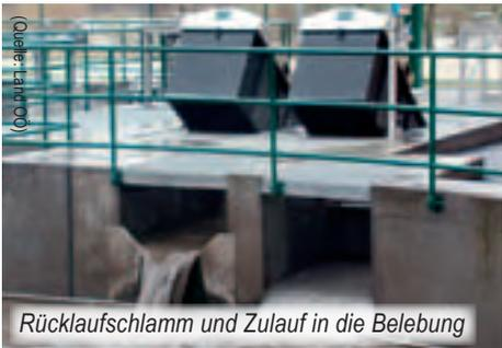
Rücklaufschlamm und Zulauf in die Belebung
