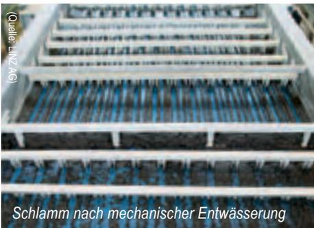
Schlamm nach mechanischer Entwässerung
