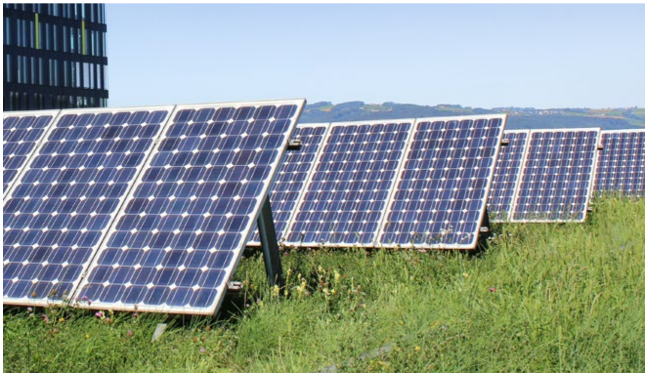
Photovoltaikanlage auf dem Dach des Landesdienstleistungszentrums in Linz, Quelle: Denkmaier
