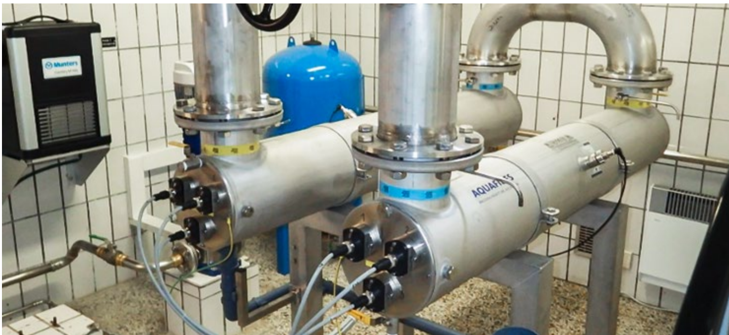
UV-Anlage zur Trinkwasserdesinfektion; Quelle: Land OÖ/Rechberger
