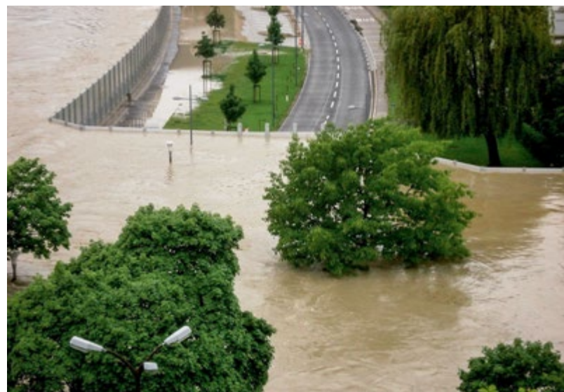
Hochwasser 2013 in Grein; Quelle: Machland-Damm GmbH
