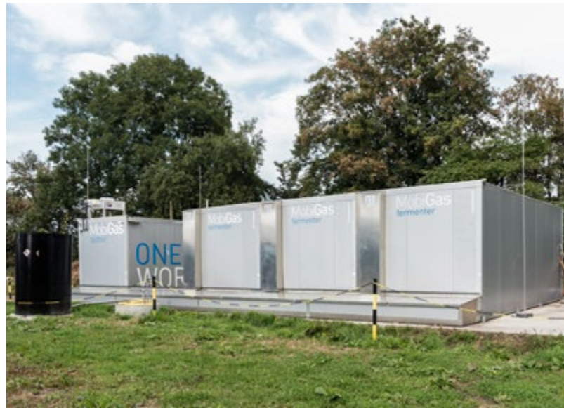
Mobile und modulare Biogasanlage; Quelle: Land OÖ, Markowetz
