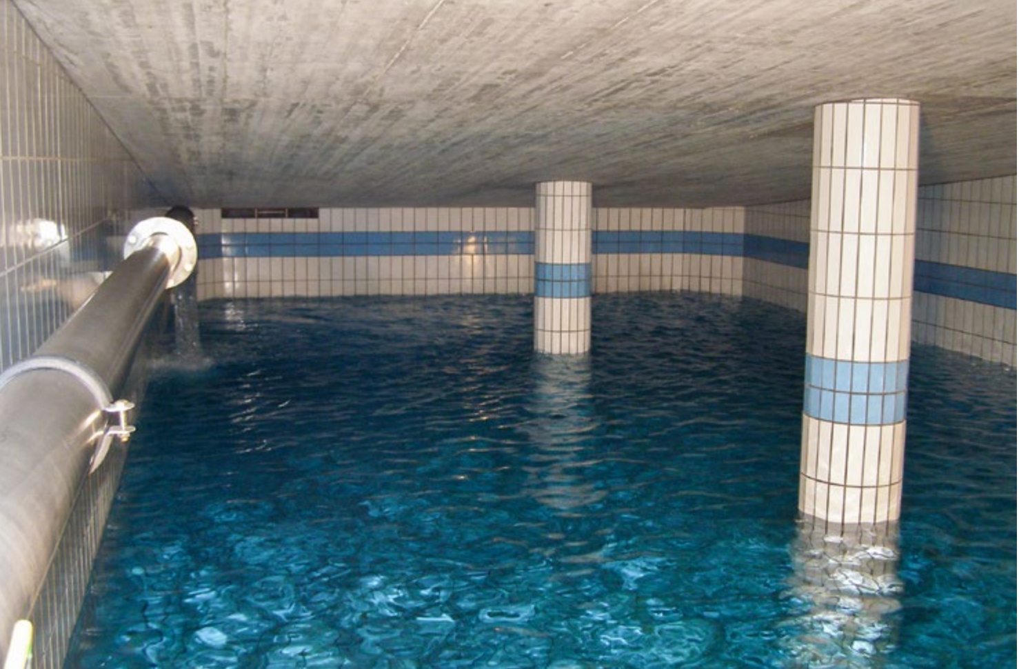
Wasserkammer eines Trinkwasserspeichers; Quelle: Land OÖ/Hartmaier
