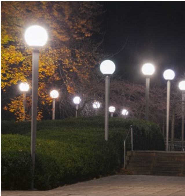
Falsche Beleuchtung strahlt Licht nach oben ab, verschwendet Energie und verursacht Lichtverschmutzung; Quelle: @lichtbildmaster - stock.adobe.com
