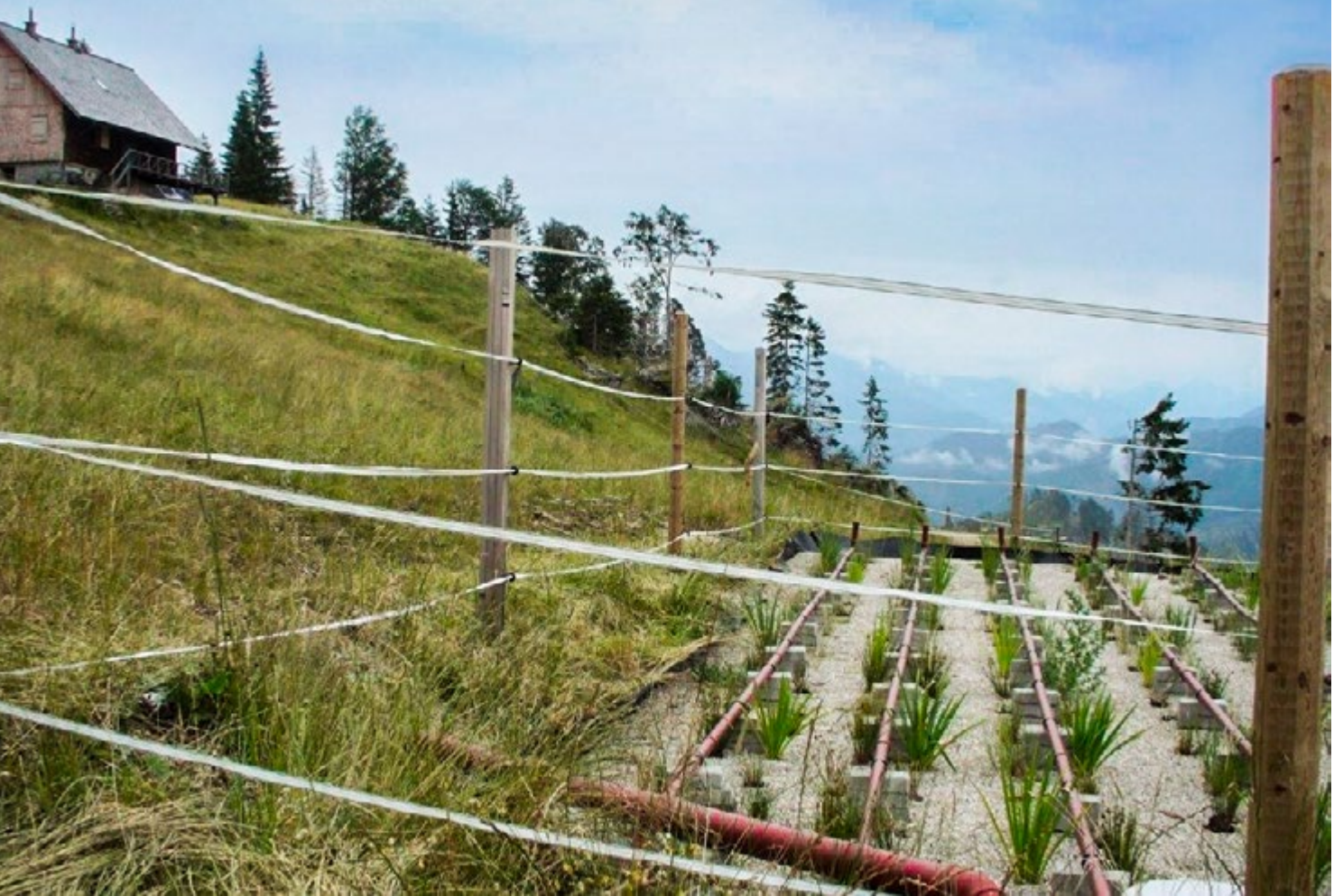
Pflanzenkläranlage im alpinen Bereich, Quelle: Manfred Mahringer
