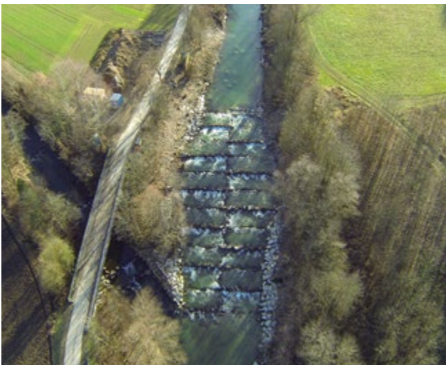
Zur fischpassierbaren Pendelrampe umgestaltetes Querbauwerk an der Krenns im Bereich der Sulzbachrampe; Quelle: Reinhold Weissenbrunner, 1a-luftbild.at
