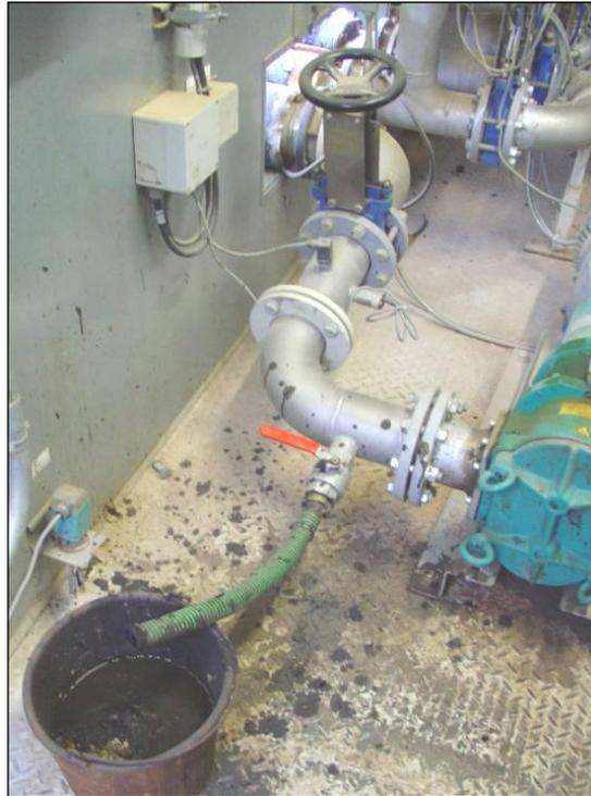
Abbildung 11: Gärrestentnahme über Bypass-Einrichtung. © Bundesgütegemeinschaft Kompost e.V. 2009.
