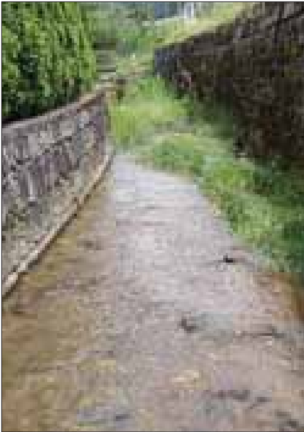
Abb. 61: Regulierter Abschnitt des Arbinger Baches in der Ortschaft Arbing
