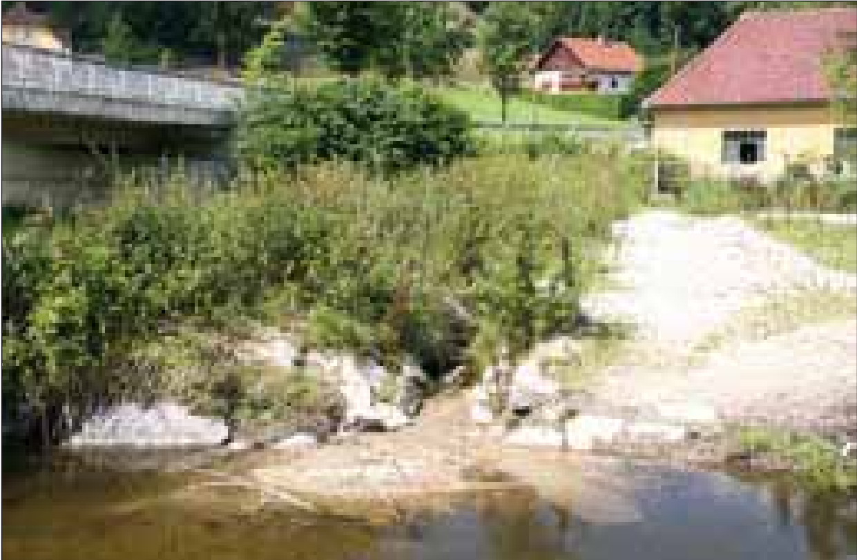
Abb. 24: Hart verbauter Zubringer flussab des Zusammenflusses von Großer und Kleiner Naarn
