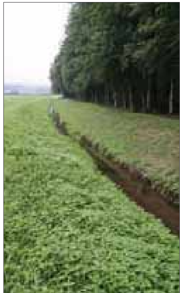
Abb. 98: Durchgängiges Trapezprofil im künstlichen Unterlauf des Deiminger Baches
