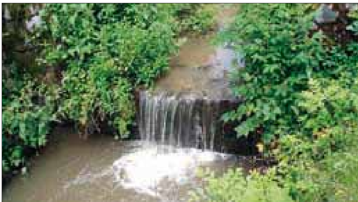
Abb. 2: Ein abgelöster Wasserstrahl ist für die aquatische Fauna nicht durchwanderbar (Foto: Arbinger Bach)
