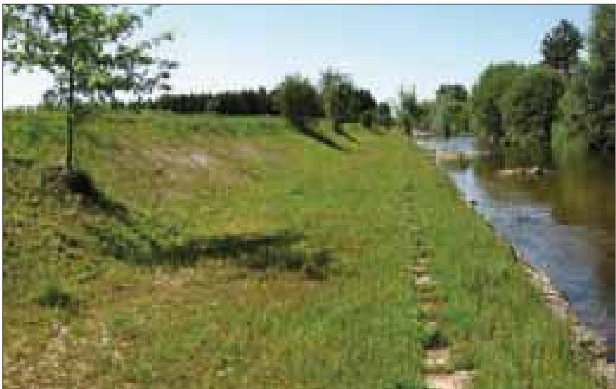
Abb. 86: Doppeltrapez-gesichertes Ufer am Unterlauf der Naarn südlich von Perg
