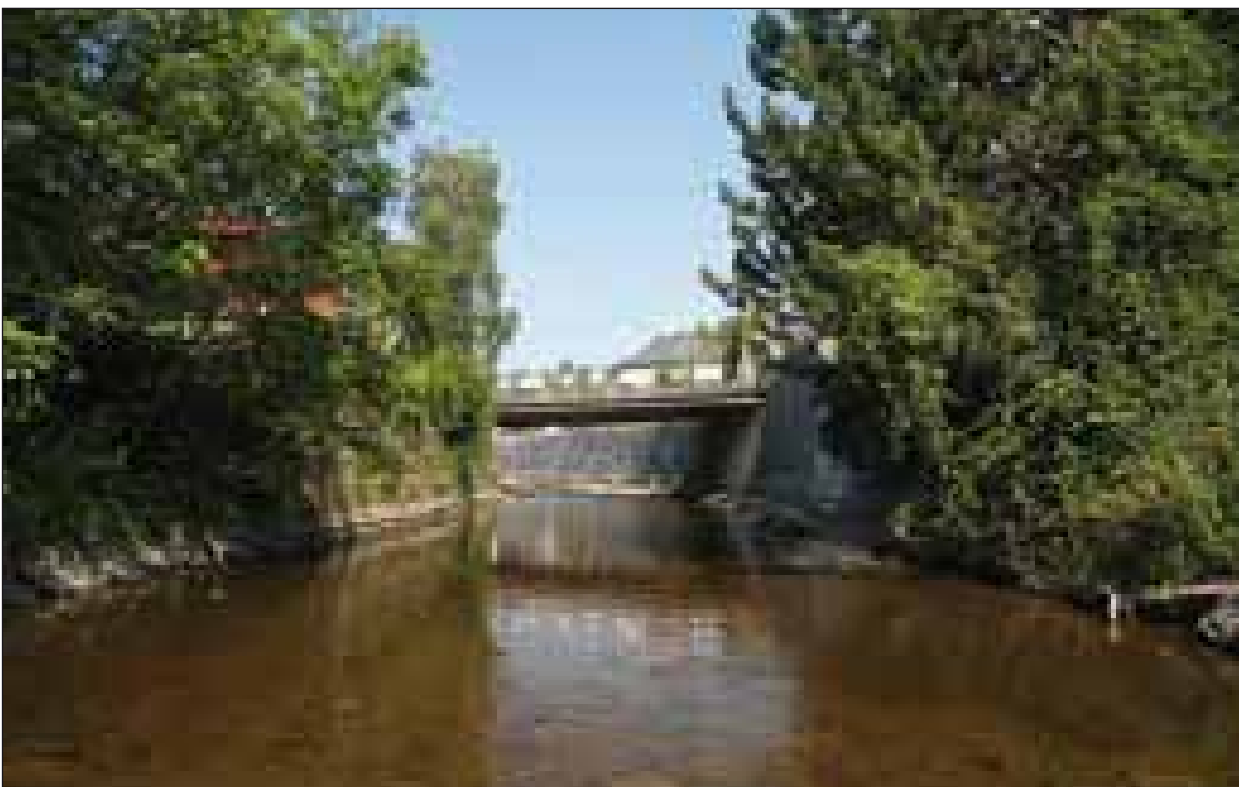
Abb. 87: Ufersicherung im Kastenprofil im Stadtgebiet von Perg
