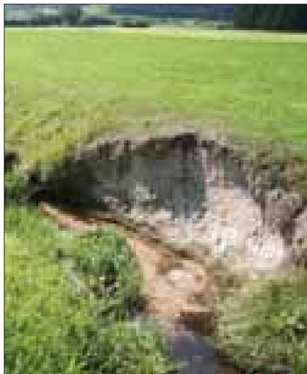
Abb. 101: Erosierte Ufer im Unterlauf des Stöckllehnerbaches
