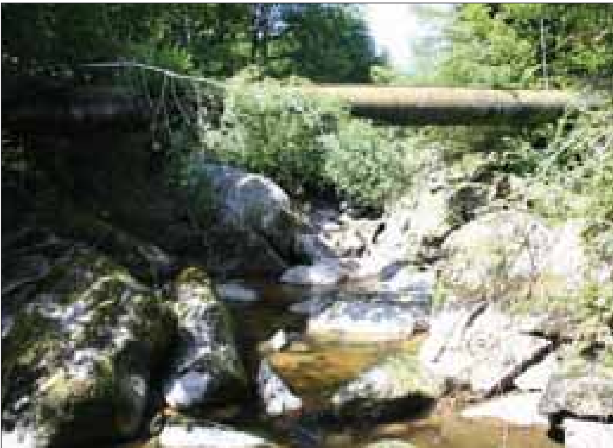
Abb. 16: Restwasserstrecke mit Ausleitungsrohr in einem Schluchtbereich der (Großen) Naarn. Die geringe Wasserführung in diesen Bereichen führt zu vielen Wanderbarrieren für die Fischfauna in diesen Abschnitten
