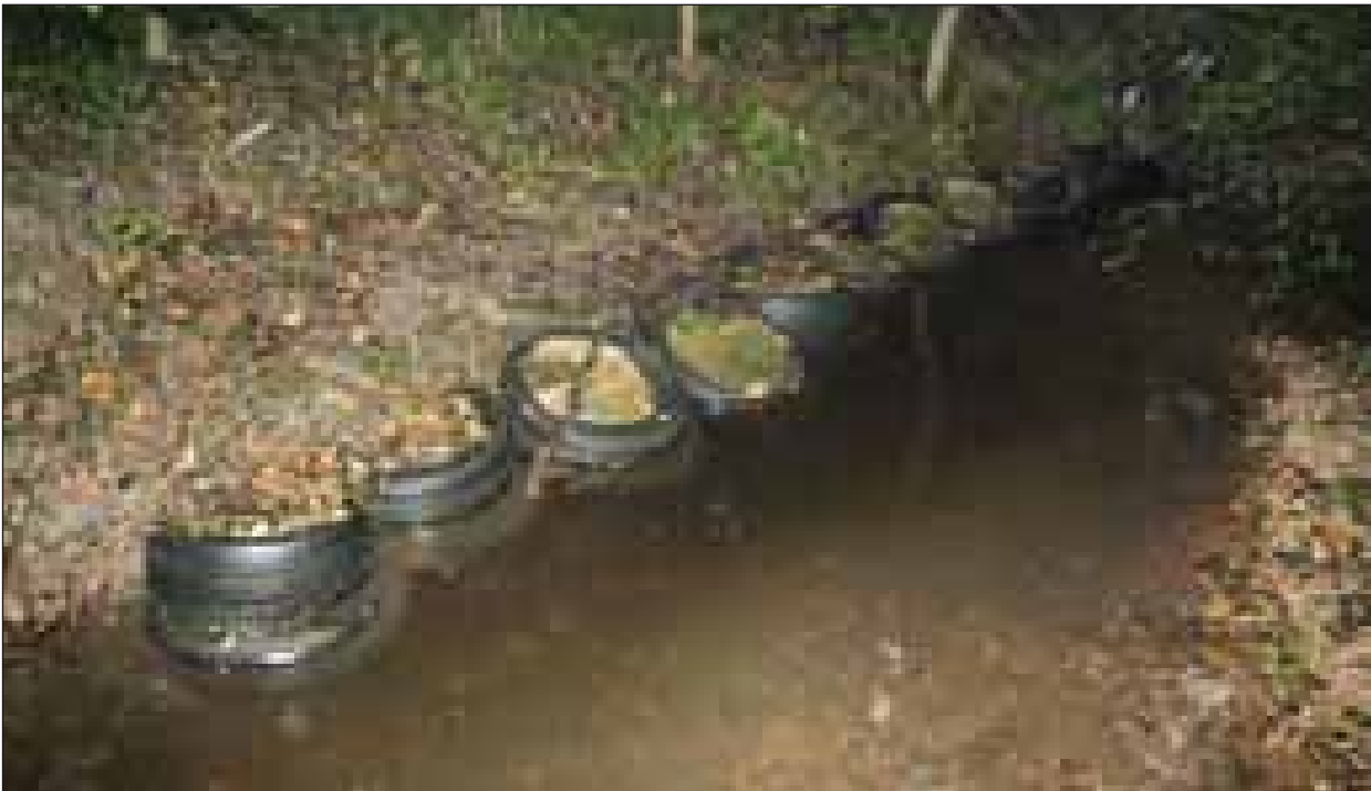
Abb. 99: Bachbettsicherung mit ausbetonierten Altreifen im Deiminger Bach
