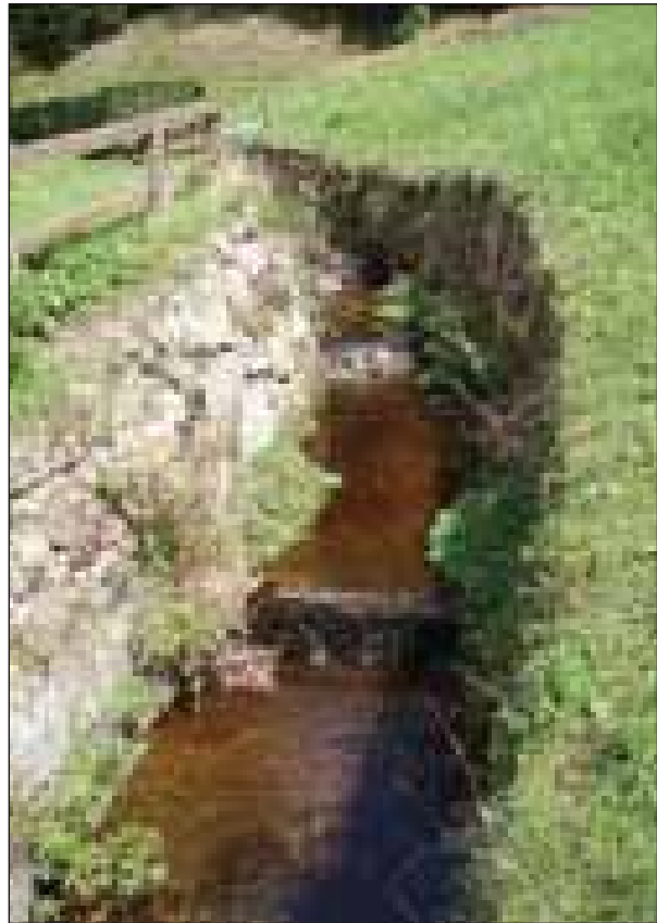
Abb. 93: Die massive Ufer- und Sohlverbauung erfordert die Bewertung mit der Zwischenklasse 3-4 in diesem Abschnitt des Weinbergbaches
