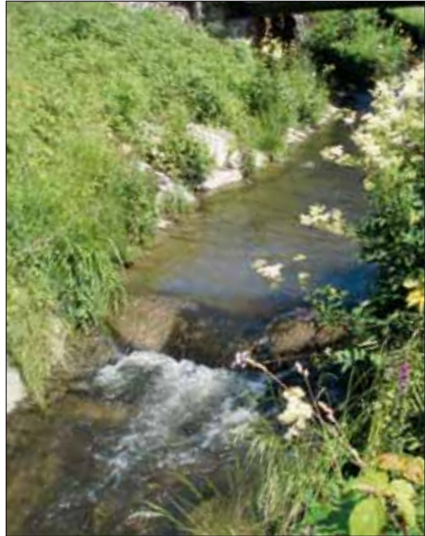
Abb. 60: Dotationsbauwerk des Tobrakanal im Tobrabach
