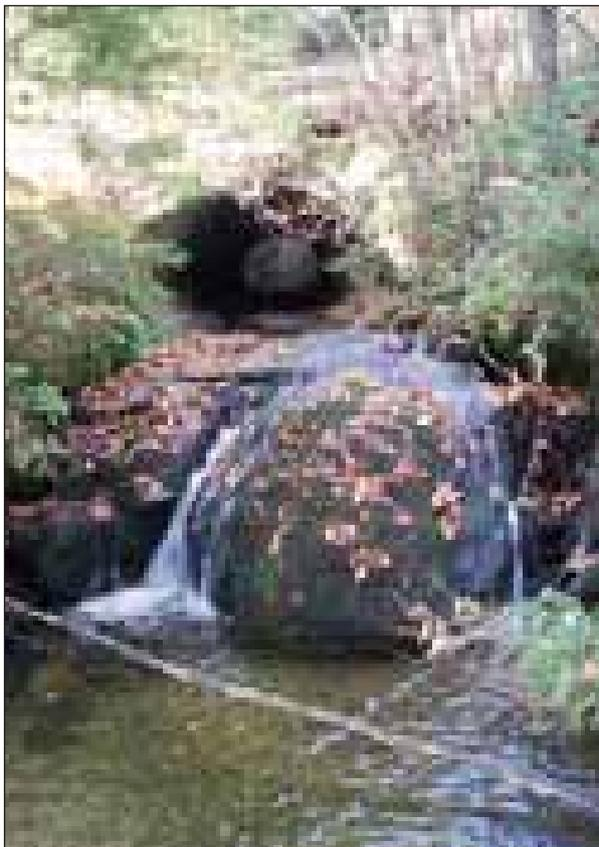
Abb. 124: Unterwasserseitige Stabilisierung eines Rohrdurchlasses im Schildbach
