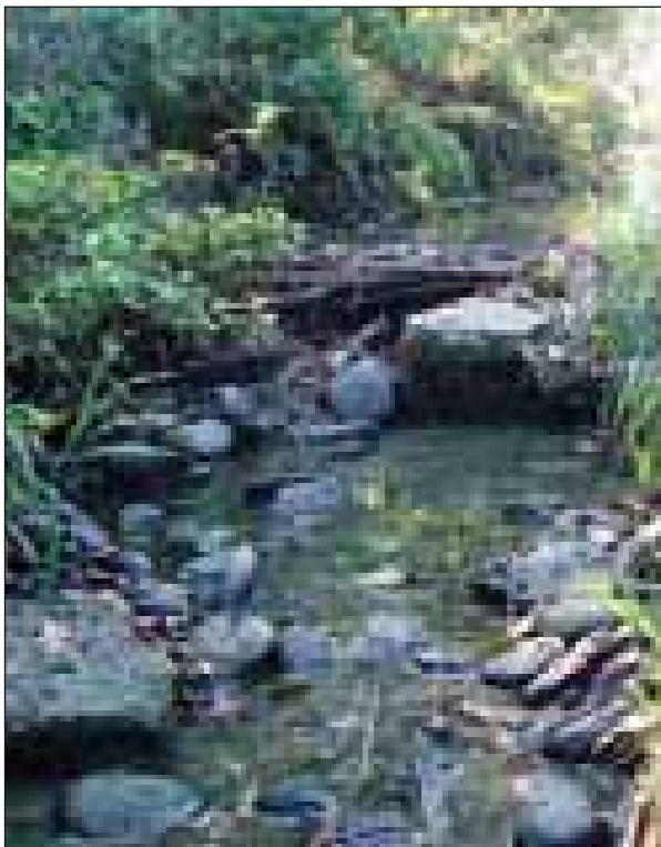
Abb. 88: Durch private Personen unprofessionell errichtete Sohlebauten
