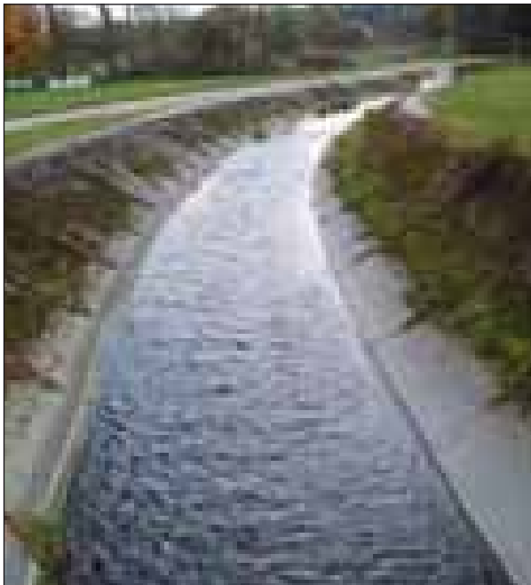
Abb. 67: Der Gurtenbach wird flussauf der Mündung in den Inn in einem Betonbett geführt
