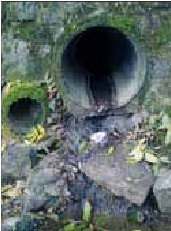
Abb. 90: Einleitung von Abwässern in den Nonsbach
