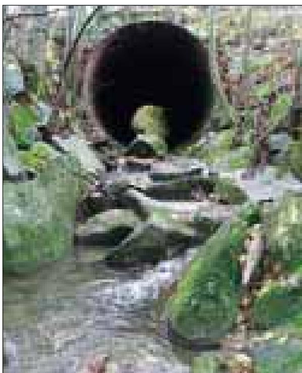
Abb. 19: Verliert sich der Wasserkörper zwischen großen Blöcken, ist eine Migration nahezu unmöglich (Foto: Gurtenbach)
