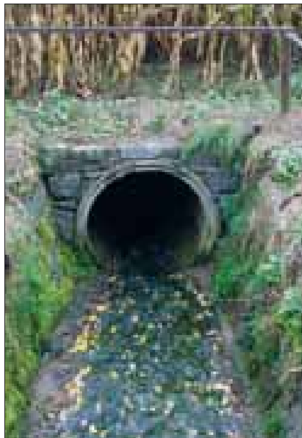
Abb. 85: Flussaufwärtiges Ende der Verrohrungsstrecke im Murhamer Bach
