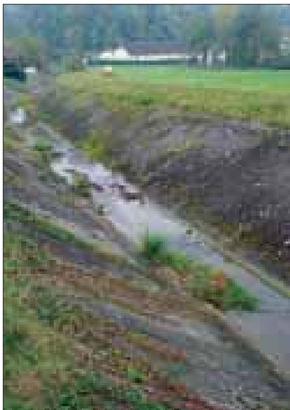
Abb. 82: Der Doblbach wird flussauf der Mündung in den Gurtenbach in einem Betonbett geführt
