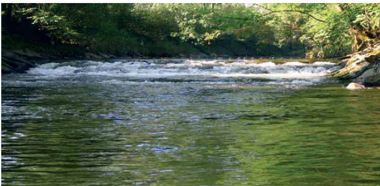
Abb. 2: Beispiel für ein Querbauwerk in der Antiesen
