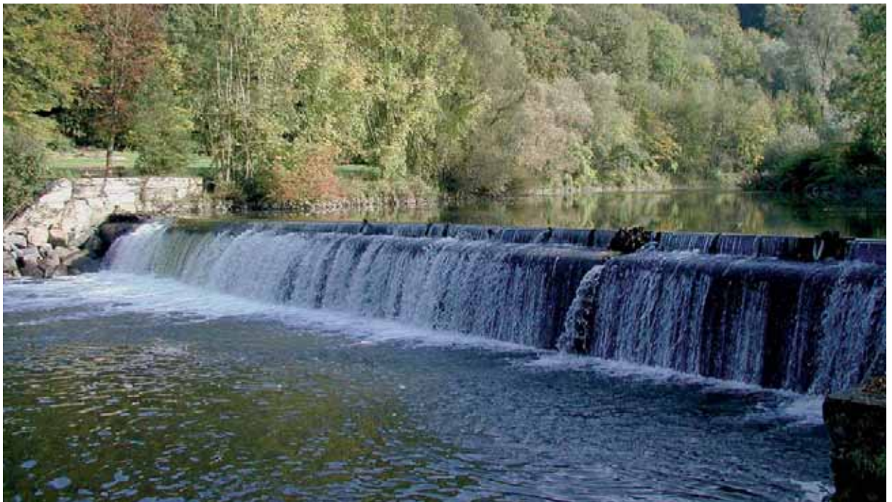
Abb. 20: Das Steilwehr in Au dient der Ausleitung von Wasser aus der Antiesen
