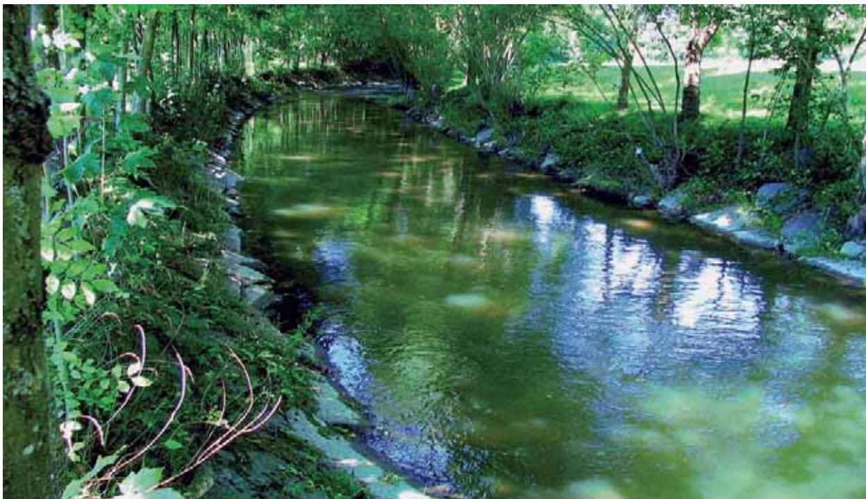
Abb. 35: Kanalisierter, mündungsnaher Abschnitt der Osternach in Ort/Innkreis (Probestrecke 2-1)
