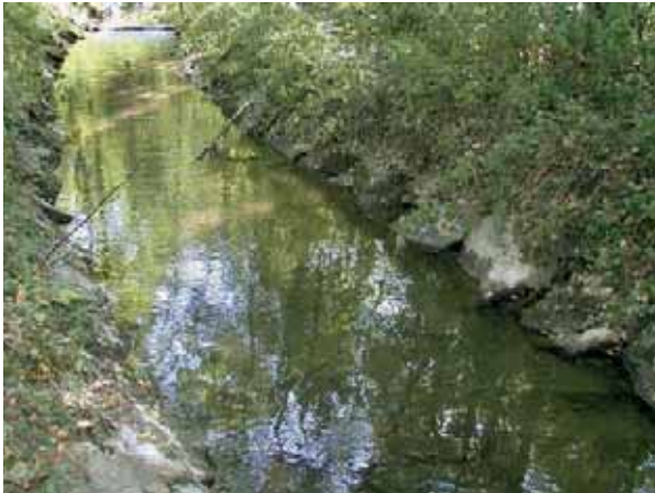
Abb. 22: Regulierter und blockwurfgesicherter Gewässerabschnitt der Antiesen
