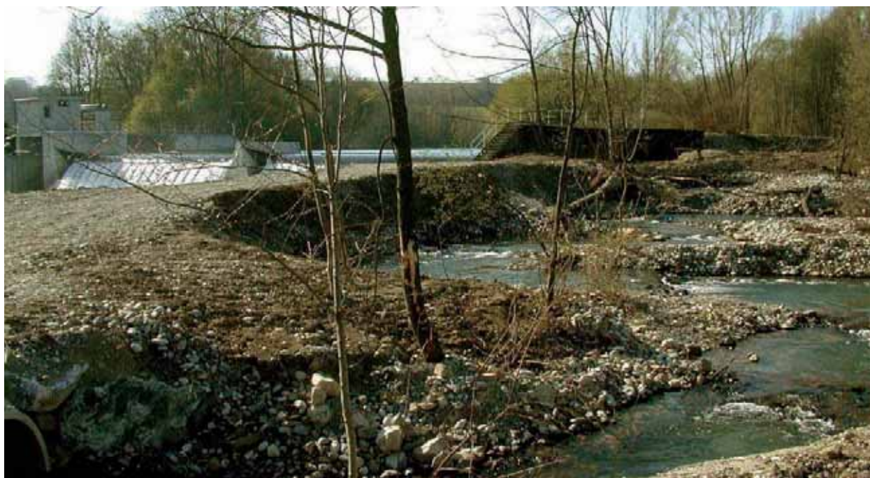
Abb. 72: Beispiel für ein naturnahes Umgehungsgerinne (Erlauf, Quelle: JUNGWIRTH)
