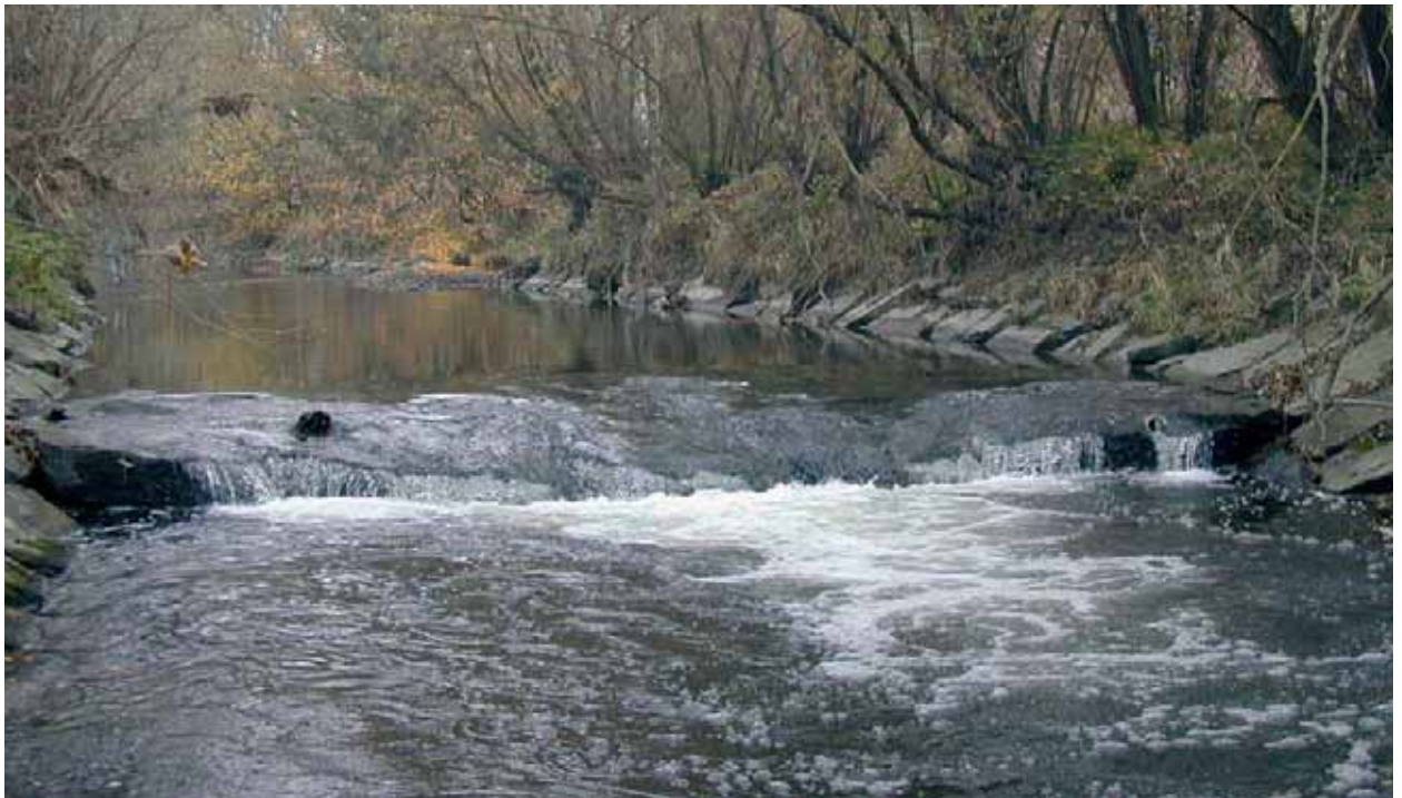
Abb. 40: Sohlschwelle im regulierten Unterlauf des Rieder Bach
