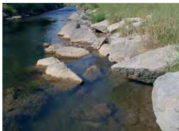
Abb. 84: Die lose, aus großen Blöcken bestehende Ufersicherung im regulierten Abschnitt 5 der Krens bei Rohr im Kremstal hat einen hohen Variationskoeffizienten der Maximaltiefen zur Folge
