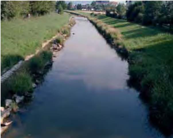
Abb. 48: Teil des regulierten Abschnittes 4 der Kreams bei Wartberg als Beispiel für eine Ufersicherung mit Blockwurf (siehe auch Abb. 51)
