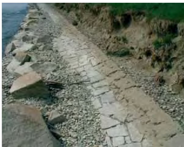
Abb. 3 und Abb. 4: Freigelegte Blockwurfsicherung an der Kreams nach dem Hochwasser im August 2002
