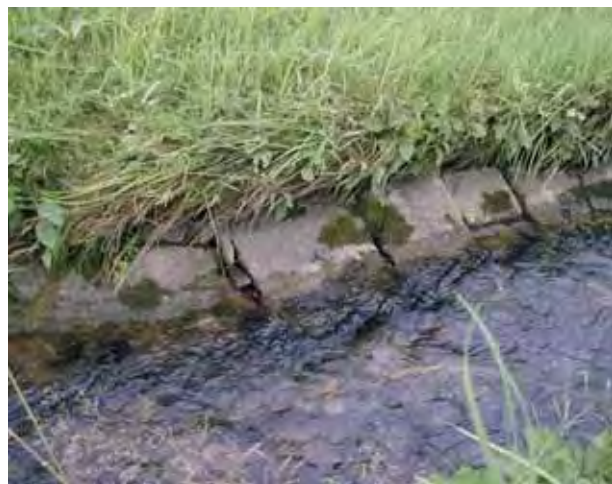
Abb. 45: Die Sohlpflasterung des Reiflbaches zwischen Straß und Burg (siehe auch Abb. 47), die eine dynamische Veränderung der Uferlinie oder der Gewässersohle praktisch unmöglich macht
