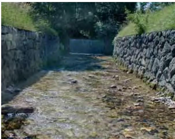
Abb. 44: Das Profil 1 im regulierten Abschnitt 1 der Krems bei Micheldorf (siehe auch Abb. 46) als Beispiel für eine Kanalisierung mit Sohlpflasterung und Ufermauer
