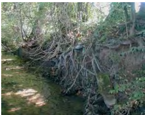
Abb. 23: Beispiel für ein unterspültes Ufer
