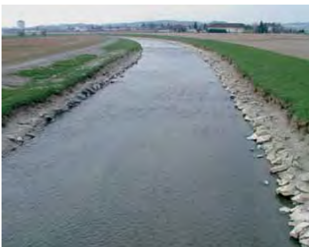
Abb. 3 und Abb. 4: Freigelegte Blockwurfsicherung an der Kreams nach dem Hochwasser im August 2002
