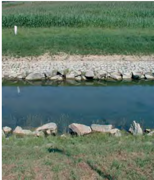
Abb. 60: Ein geradliniges Flussbett kann über weite Strecken nur mit massiven Uferverbauungen erzwungen werden
