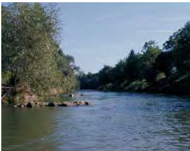
Abb. 21: Beispiel für eine Buhne in der Kreams
