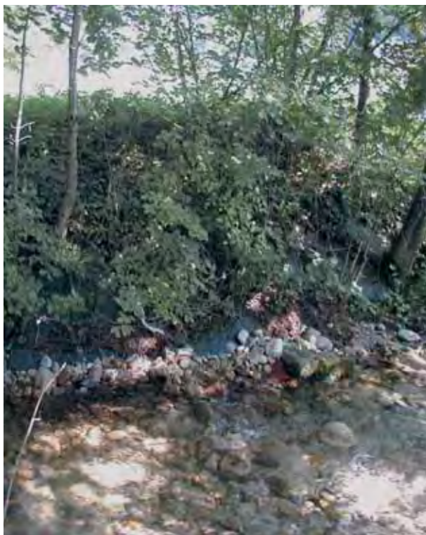
Abb. 78: Von Geschiebe überlagerte Pflasterung des Profils 1 im regulierten Abschnitt 1 bei Micheldorf
