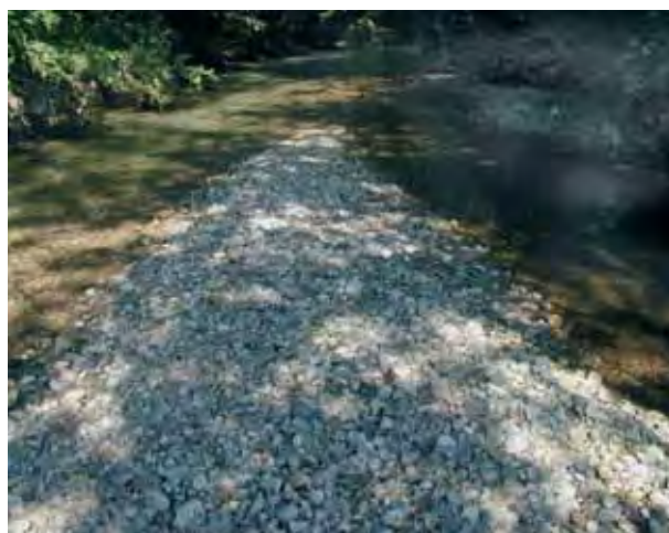
Abb. 16: Beispiel einer Schotterbank im Stromstrich der Krems
