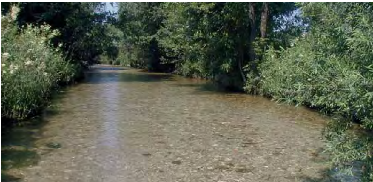
Abb. 110: Der regulierte Abschnitt 2 der Kreams bei Inzersdorf als Beispiele einer Monotonisierung des Gewässers. Die Kreams weist hier eine geringe Variabilität der Profilbreiten und Tiefen auf
