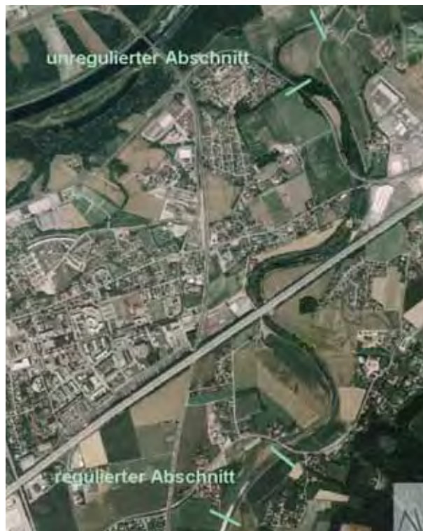
Abb. 80: Luftbildaufnahme des regulierten und unregulierten Abschnittes 8 bei Ansfelden
