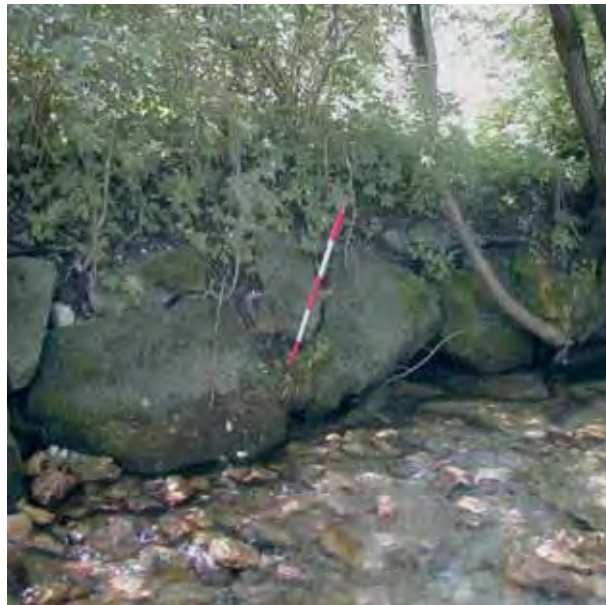
Abb. 77: Blockwurfsicherung am Ufer des Profils 2 im regulierten Abschnitt 1 bei Micheldorf. Die rot-weiße Stange markiert das Profil
