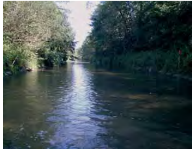
Abb. 49: Das Profil 2 des regulierten Abschnittes 10 des Sulzbaches bei Rohr im Kremstal (siehe auch Abb. 52) weist Blockwurfsicherung am Ufer auf und die Sohle ist ungefähr alle 60 m mit Sohlgerurten stabilisiert
