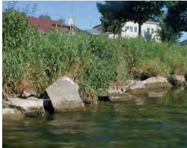
Abb. 20: Beispiel für lose Steinsicherungen beziehungsweise Blockwurf in der Kreams
