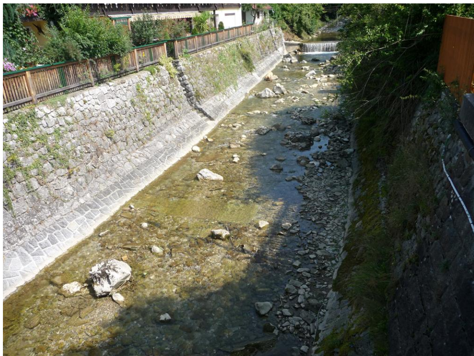
Abb. 2: Weyregger Bach - Mündungsbereich (Foto: Mag. Thomas Anzböck)
