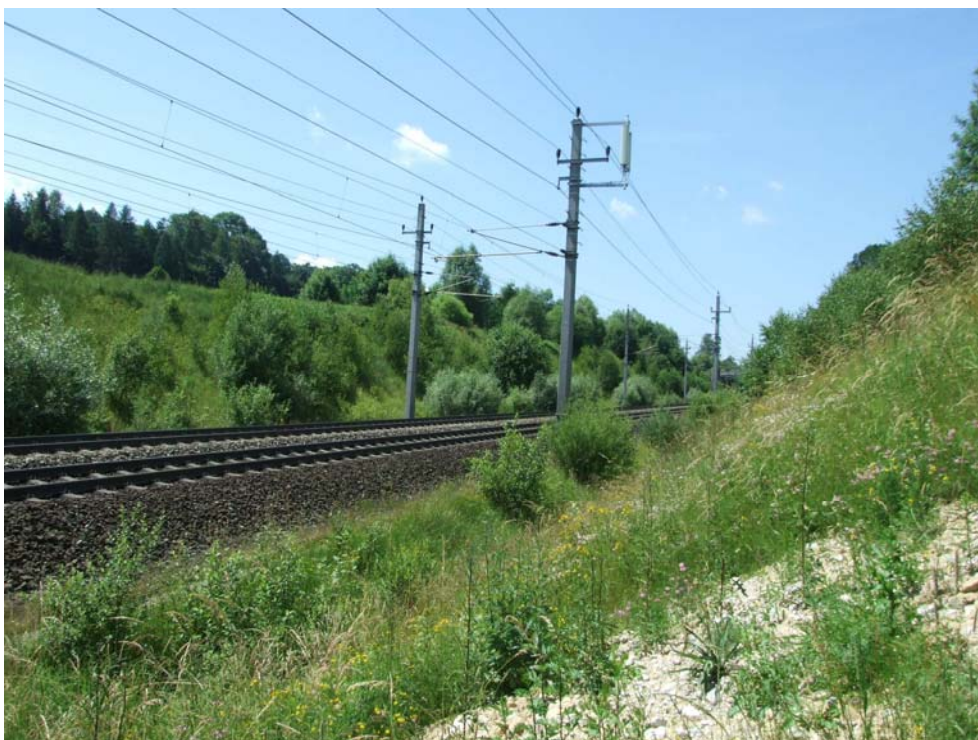
Abb. 7: Entlang Vöcklabrucks Bahnstrecke eingebettet zwischen kleinen Böschungen, die teilweise von Kleinstwaldflächen und von artenreichen Blumenwiesen bewachsen sind (Foto: Mag. Harald Hackl)
