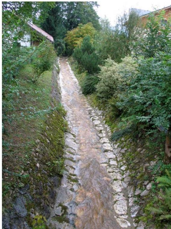
Abb. 16: Die Bäche sind im Mündungs- und Ortsbereich größtenteils hart verbaut (Ufer- und Sohlsicherungen).
