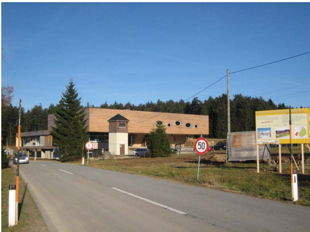
41342025: Neubau des Langlaufzentrums in Schöneben (Foto: grün integral)
