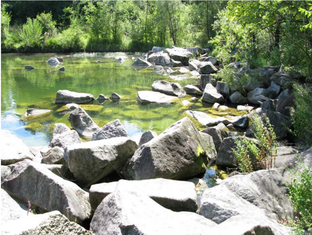
Abb. 17: Uferbefestigung mit grobblockigem Gesteinsmaterial (Foto: REGIOPLAN INGENIEURE Salzburg GmbH)
