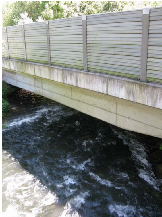
Abb. 4: Stark begradigtes und befestigtes Fließgewässer mit Eisenbahnbrücke im Ortsteil Oedt (Foto: REGIOPLAN INGENIEURE Salzburg GmbH)
