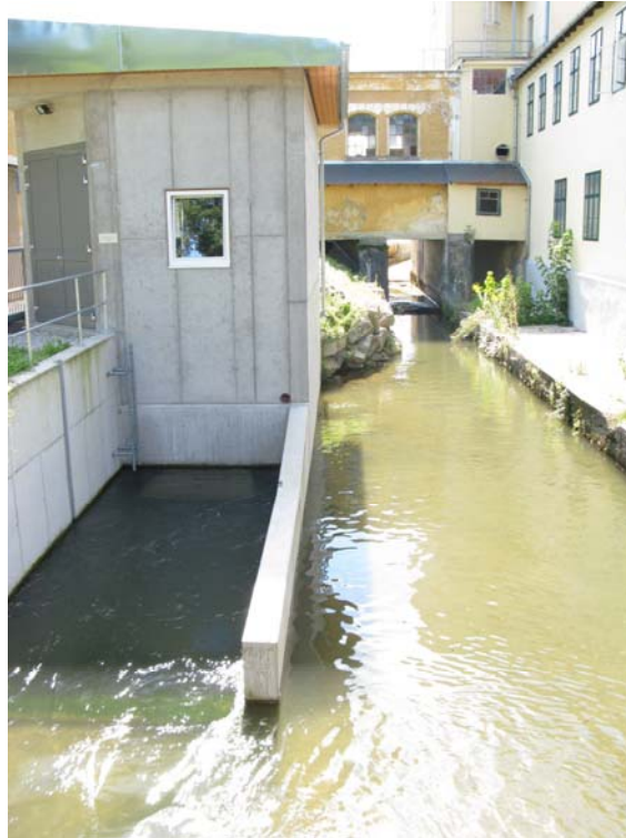
Abb. 21: Ausfluss des Mühlbachs aus der Mühle bzw. Kleinkraftwerk (Foto: REGIOPLAN INGENIEURE Salzburg GmbH)
