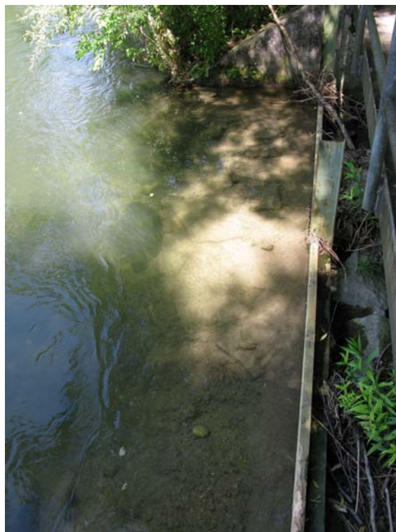
Abb. 8: Teilweise befestigte Böschung und Flusssohle im Auenbereich (Foto: REGI-OPLAN INGENIEURE Salzburg GmbH)
