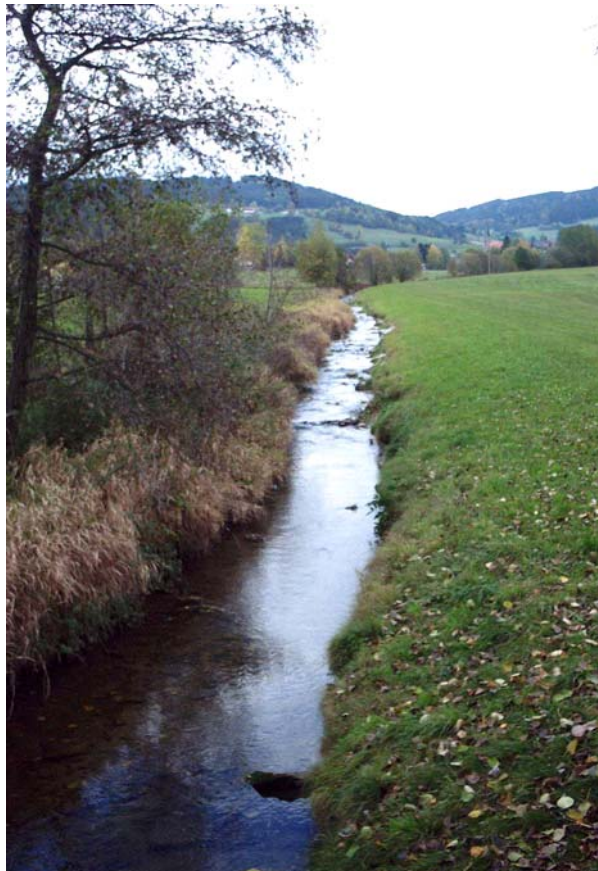
Foto 8: Feistritz flussab St. Oswald; der Bach ist reguliert und begradigt; Uferbegleitgehölze lückig oder fehlen zur Gänze
