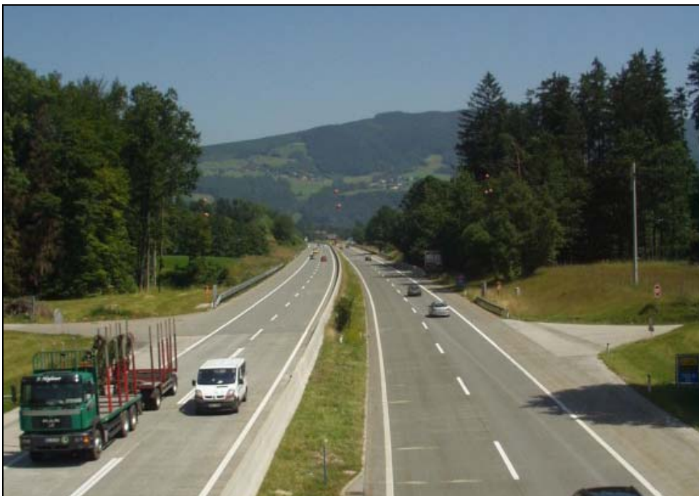
Abb. 16: Westautobahn westlich der Ausfahrt Mondsee [Photo: S. ZOBL, 10. August 2004]
