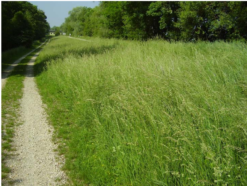
Abb. 9: Hochwasserschutzdamm des Inn beim Kraftwerk Oberberg (Foto: Technisches Büro Eisner)
