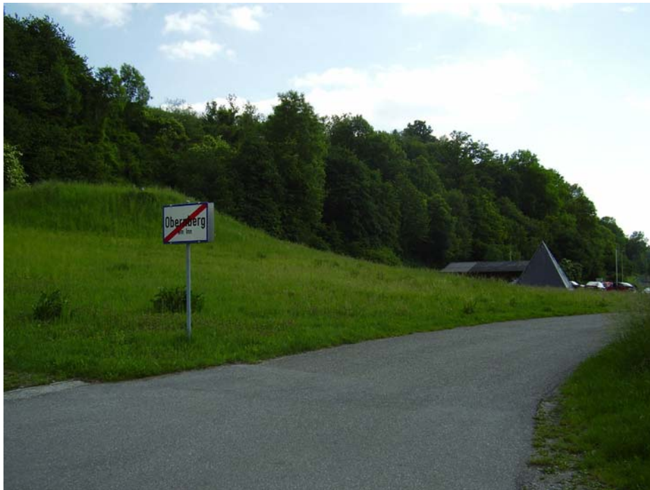
Abb. 7: Geländeböschung beim Kraftwerk Oberberg (Foto: Technisches Büro Eisner)
