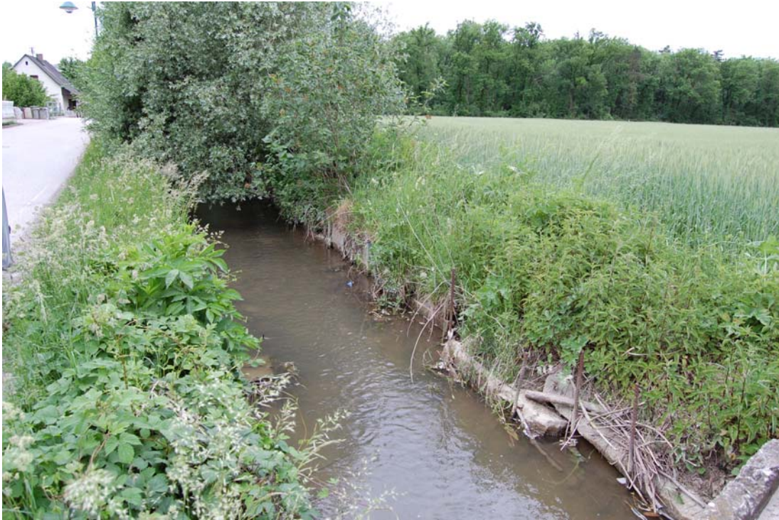
Abb. 9: Fließgewässer Nr. 2006, an dieser Stelle verbaut (Foto: REGIOPLAN INGENIEURE Salzburg GmbH)
