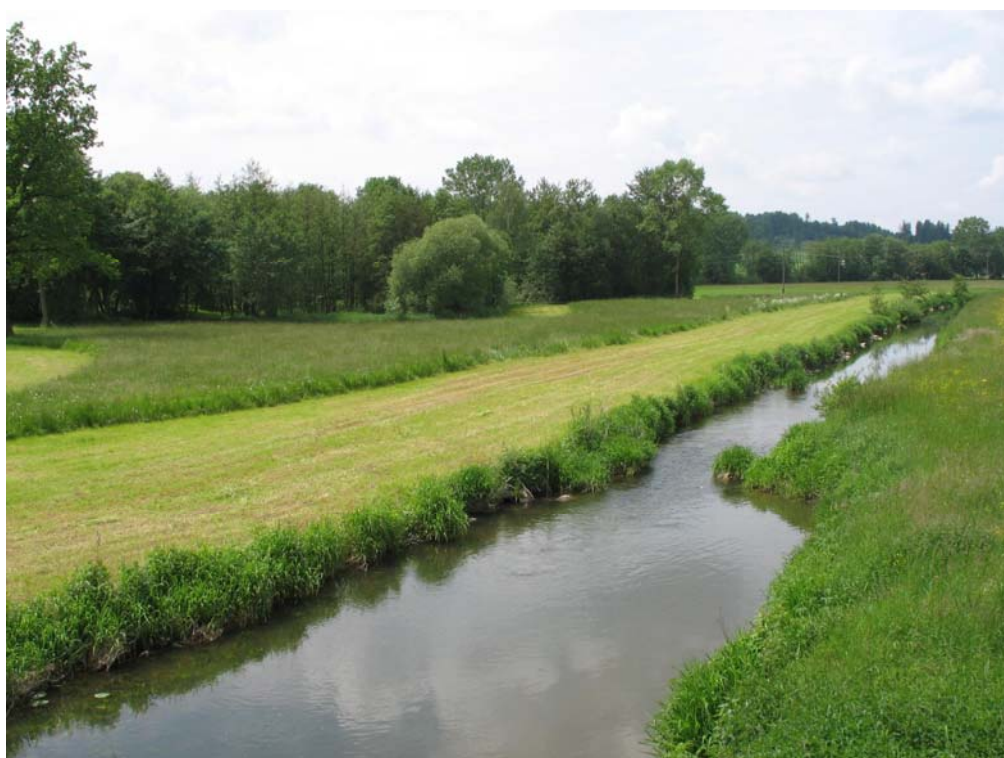
Abb. 4: Regulierter im Lauf verlegter Bach zwischen Maiden und Haid. Im Hintergrund ist die alte Linienführung anhand des ehemaligen Ufergehölzstreifens erkennbar (Foto: Grossauer, Ingenieurkonsulent für Landschaftsplanung, Gmünd).
