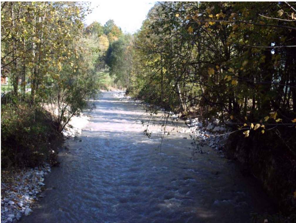
Foto 4: Grünaubach, Blick flussauf in Richtung Osten bei der Brücke zur Enzenbachmühle
