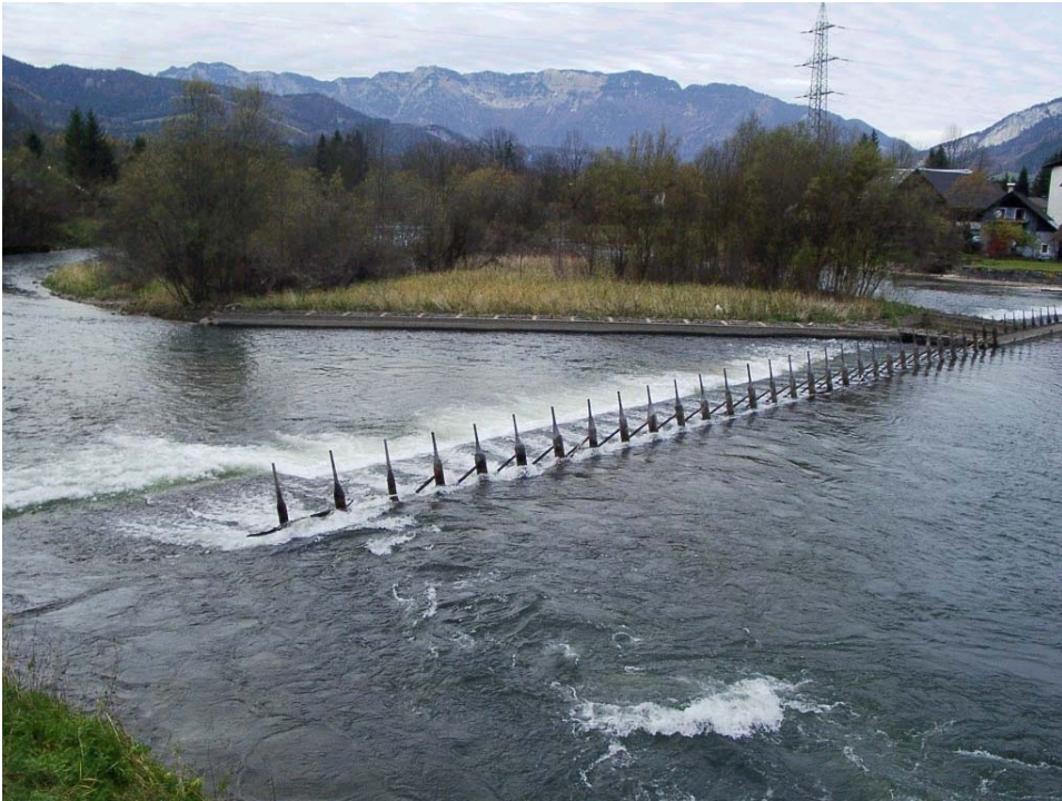
Foto 7: Wehranlage beim Ausfluss der Traun aus dem Hallstättersee bei Steeg mit einer alten bewachsenen Insel
