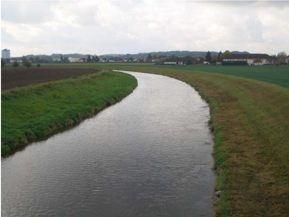
Abb. 11: Regulierter Abschnitt der Krems bei Kremsdorf (Foto: Technisches Büro Eisner)
