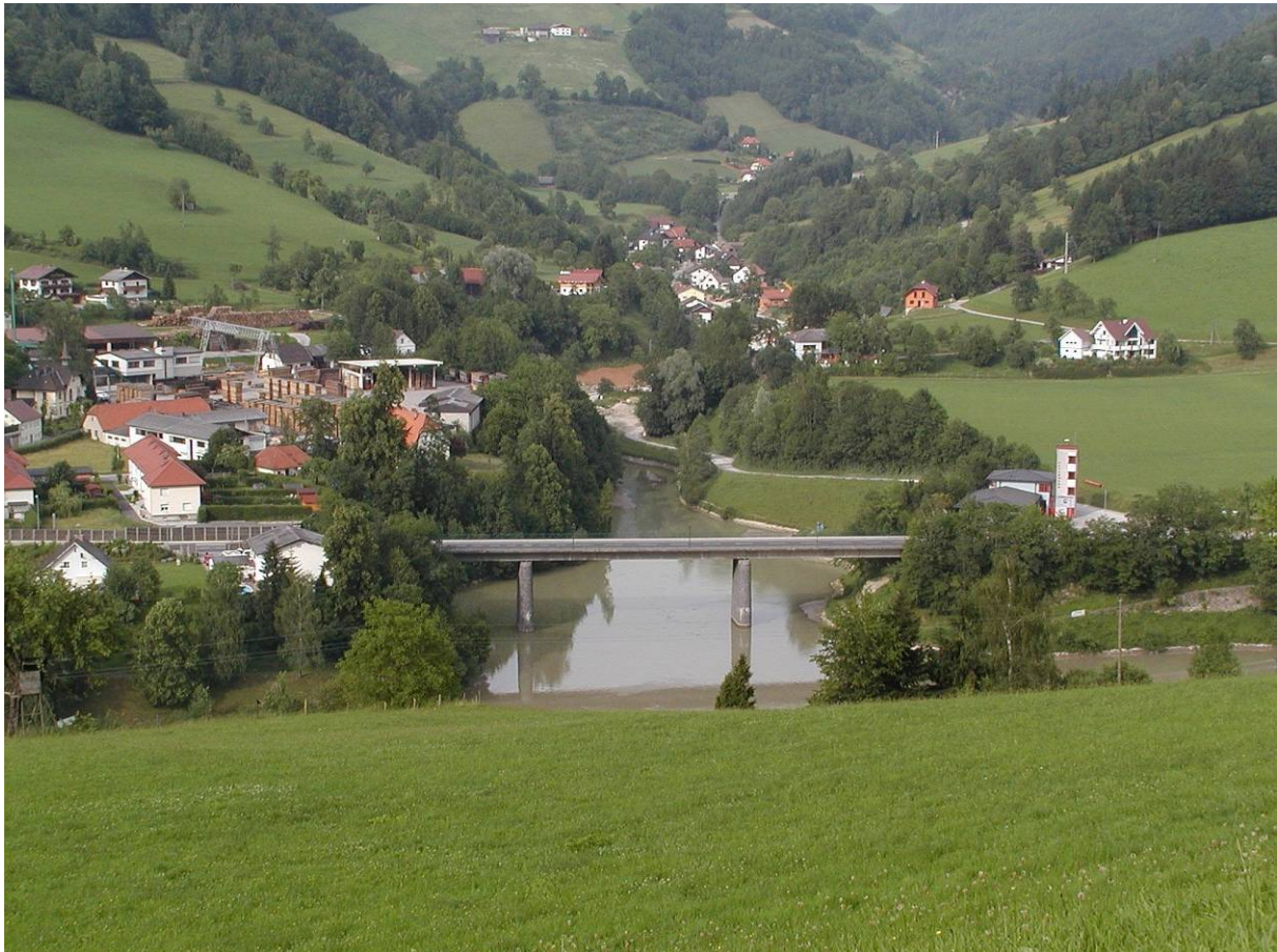
Abbildung 20: Die aufgestaute Mündung des Stiedelsbach in die Enns.
